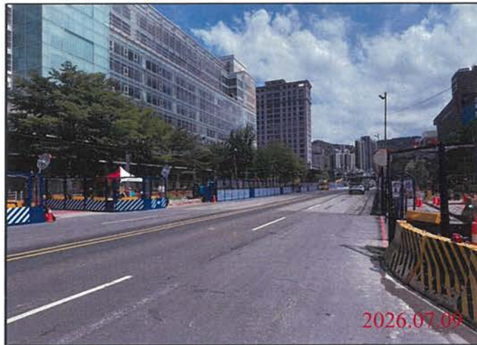
巡查日期地點：115.07.09 尾軌 照片說明：路面狀況
