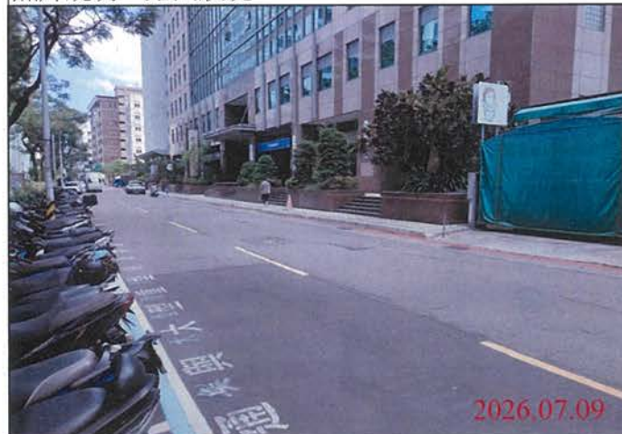
巡查日期地點：115.07.09 Y31車站 照片說明：路面狀況
