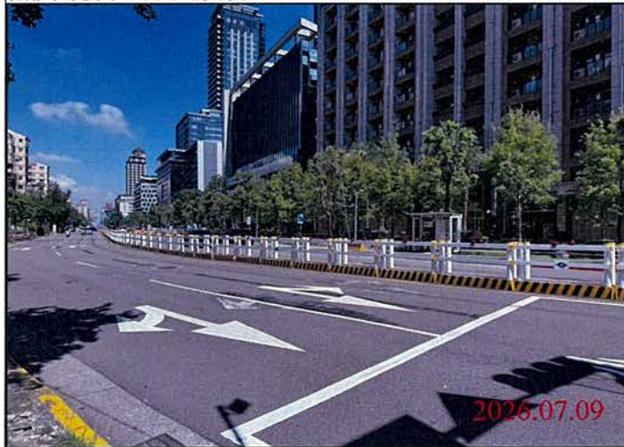
巡查日期地點：115.07.09 Y30車站 照片說明：路面狀況
