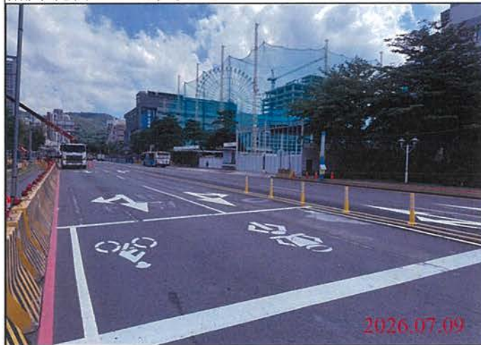
巡查日期地點：115.07.09 尾軌 照片說明：路面狀況
