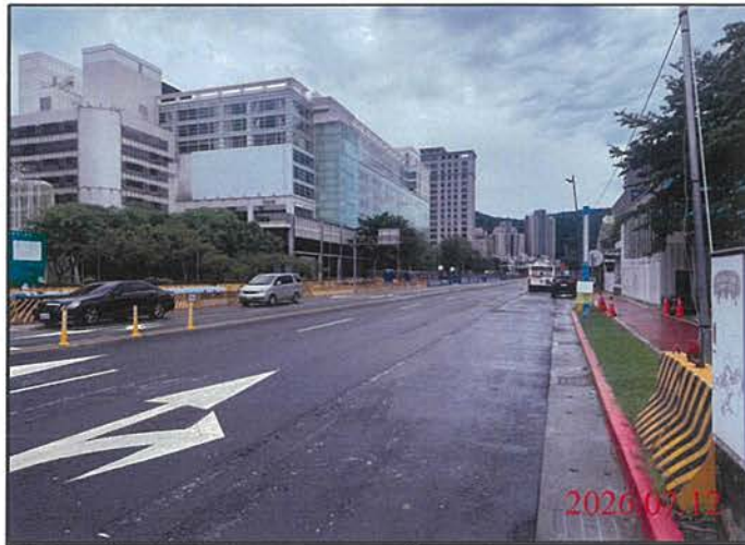
巡查日期地點：115.07.12 尾軌 照片說明：路面狀況
