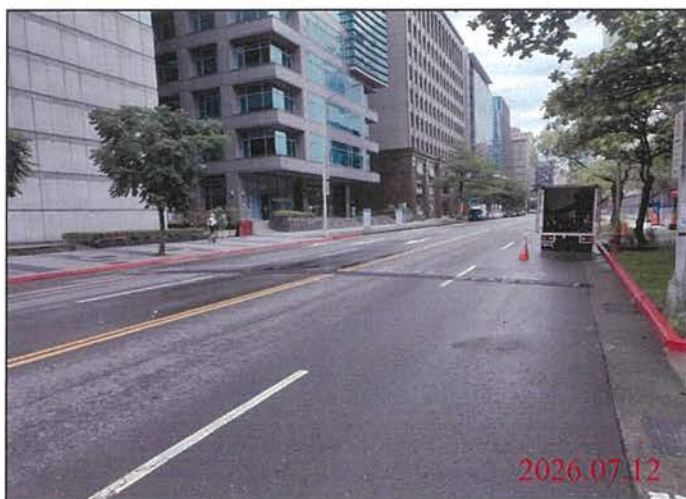
巡查日期地點：115.07.12 Y31車站 照片說明：路面狀況
