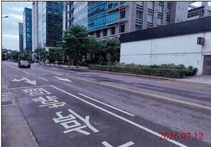
巡查日期地點：115.07.12 Y32車站 照片說明：路面狀況
