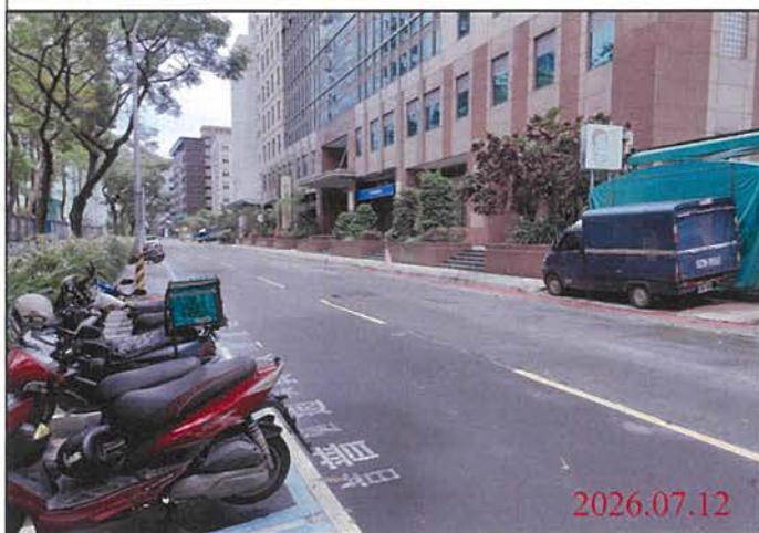
巡查日期地點：115.07.12 Y31車站 照片說明：路面狀況
