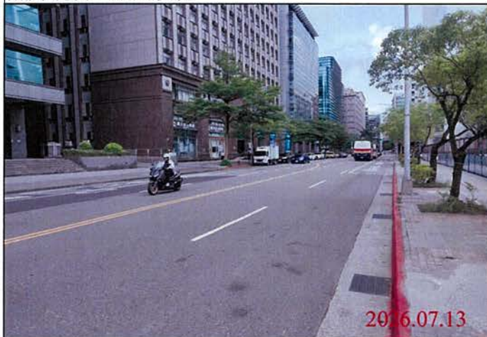
巡查日期地點：115.07.13 Y31車站 照片說明：路面狀況
