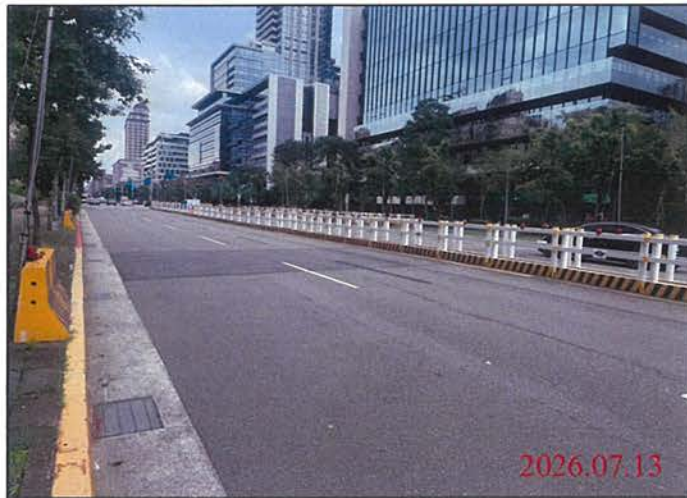
巡查日期地點：115.07.13 Y30車站 照片說明：路面狀況
