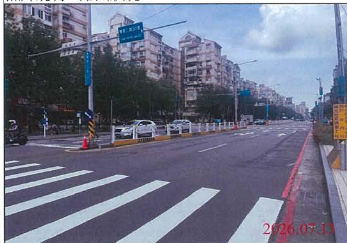
巡查日期地點：115.07.13 Y30車站 照片說明：路面狀況
