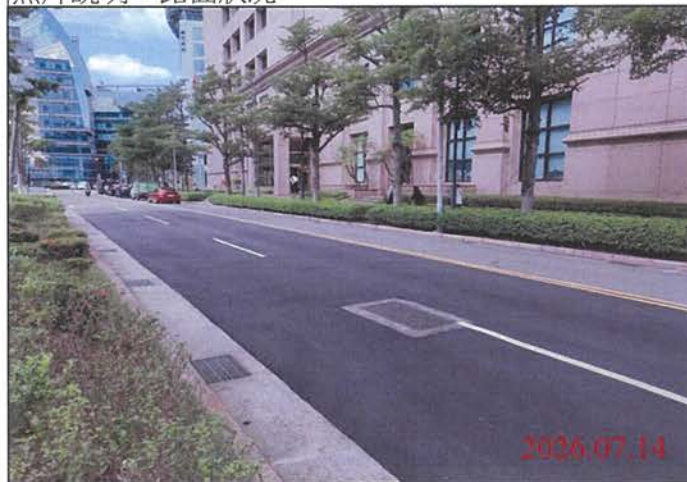
巡查日期地點：115.07.14 Y32車站 照片說明：路面狀況
