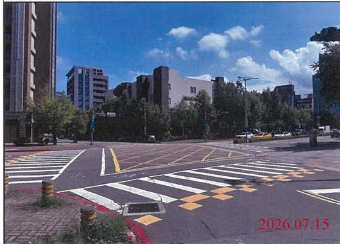
巡查日期地點：115.07.15 Y30車站 照片說明：路面狀況
