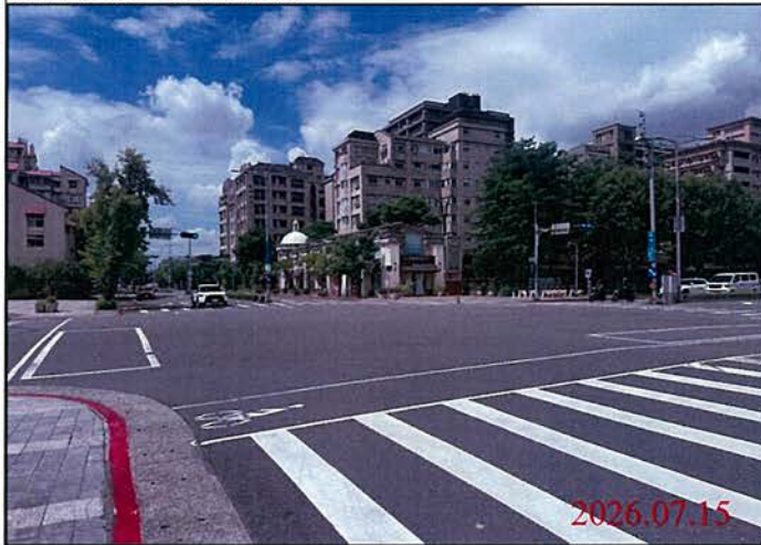
巡查日期地點：115.07.15 尾軌 照片說明：路面狀況
