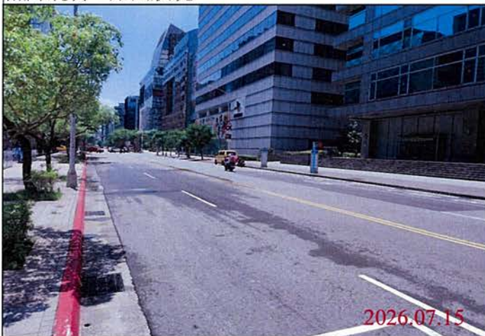
巡查日期地點：115.07.15 Y31車站 照片說明：路面狀況
