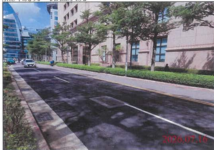
巡查日期地點：115.07.16 Y32車站 照片說明：路面狀況
