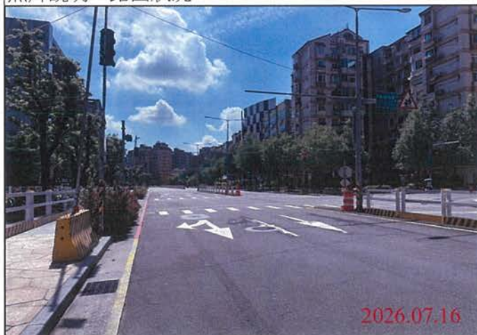
巡查日期地點：115.07.16 Y30車站 照片說明：路面狀況
