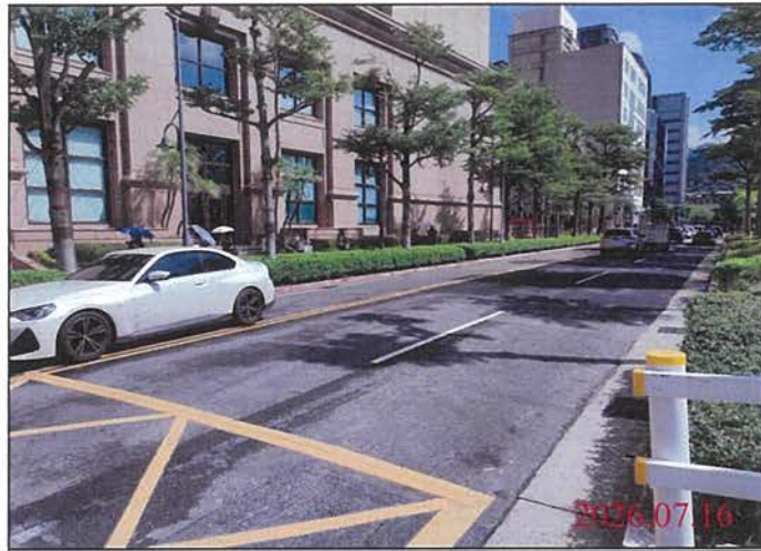
巡查日期地點：115.07.16 Y32車站 照片說明：路面狀況
