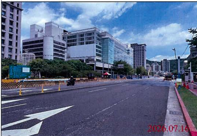
巡查日期地點：115.07.16 尾軌 照片說明：路面狀況
