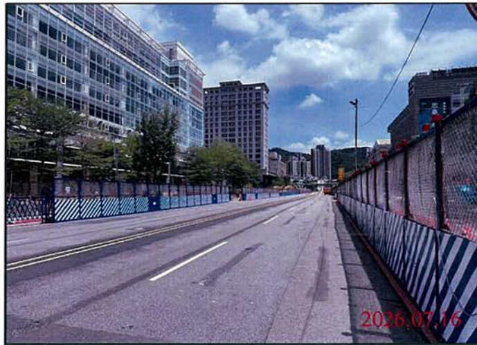
巡查日期地點：115.07.16 尾軌 照片說明：路面狀況
