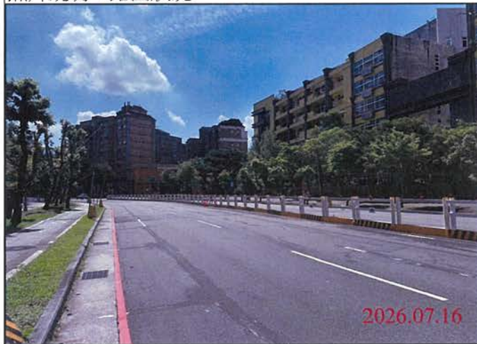
巡查日期地點：115.07.16 Y30車站 照片說明：路面狀況
