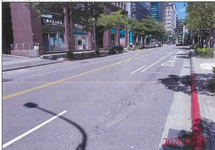
巡查日期地點：115.07.17 Y31車站 照片說明：路面狀況
