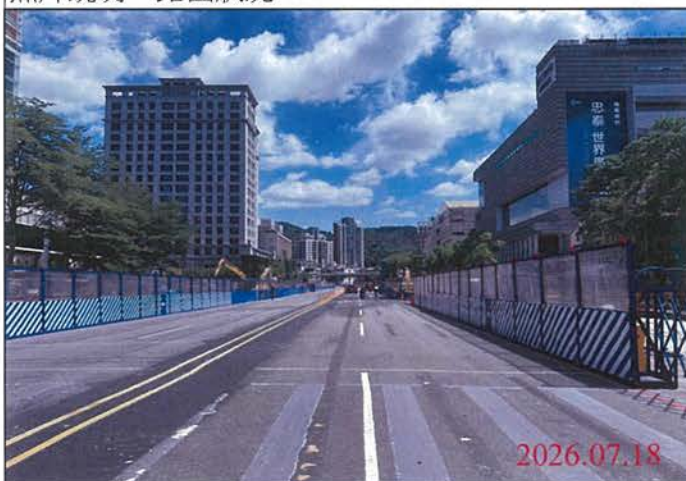
巡查日期地點：115.07.18 尾軌 照片說明：路面狀況
