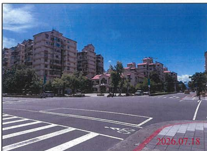
巡查日期地點：115.07.18 尾軌 照片說明：路面狀況
