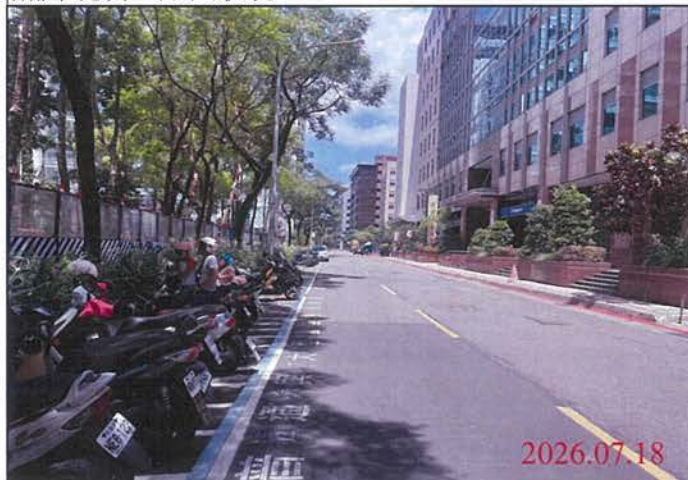
巡查日期地點：115.07.18 Y31車站 照片說明：路面狀況
