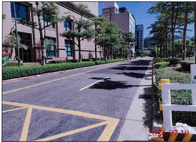
巡查日期地點：115.07.19 Y32車站 照片說明：路面狀況
