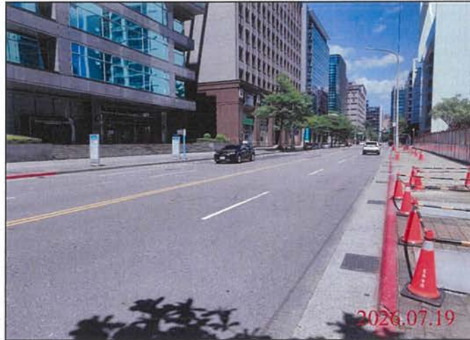
巡查日期地點：115.07.19 Y31車站 照片說明：路面狀況
