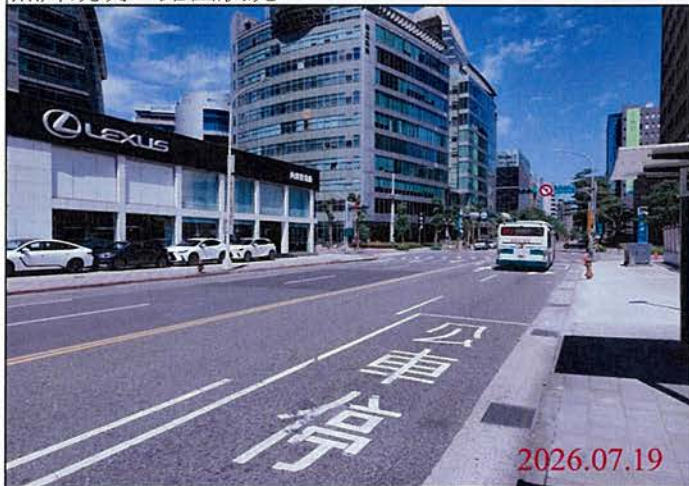
巡查日期地點：115.07.19 Y32車站 照片說明：路面狀況
