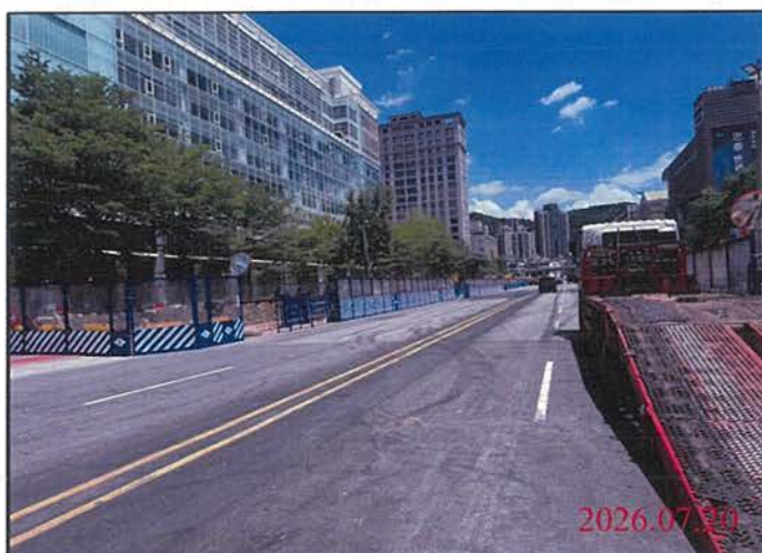
巡查日期地點：115.07.20 尾軌 照片說明：路面狀況
