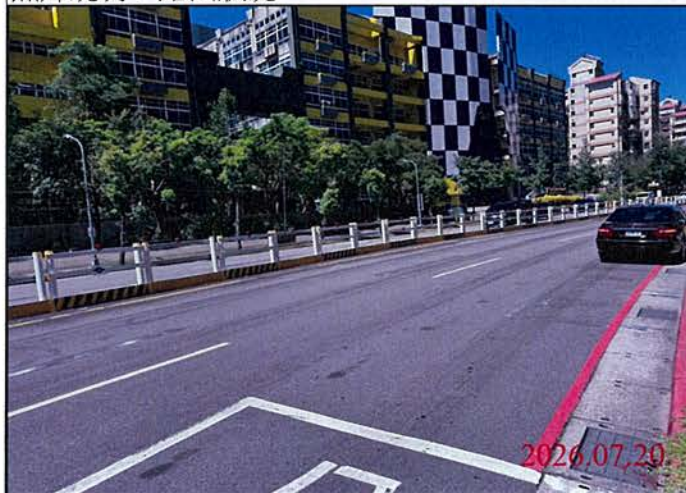
巡查日期地點：115.07.20 Y30車站 照片說明：路面狀況
