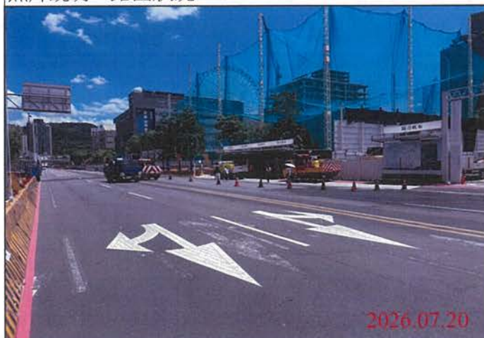
巡查日期地點：115.07.20 尾軌 照片說明：路面狀況
