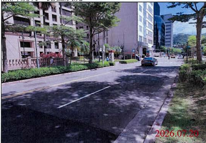
巡查日期地點：115.07.20 Y32車站 照片說明：路面狀況
