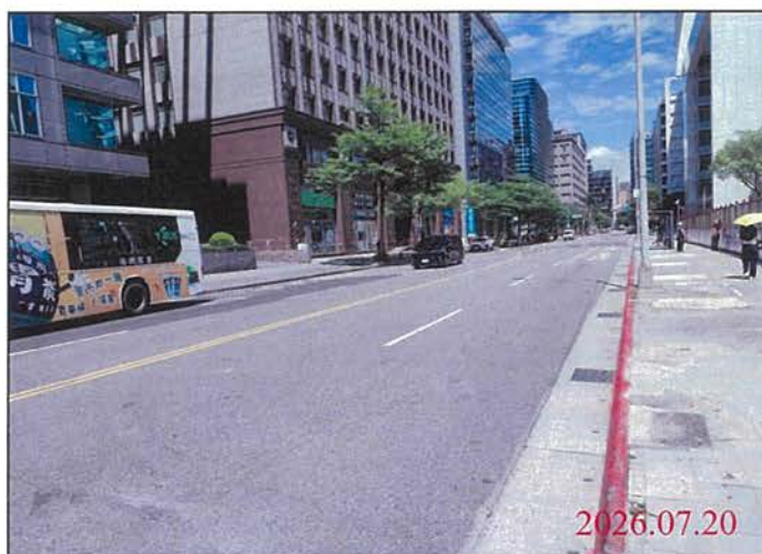
巡查日期地點：115.07.20 Y31車站 照片說明：路面狀況
