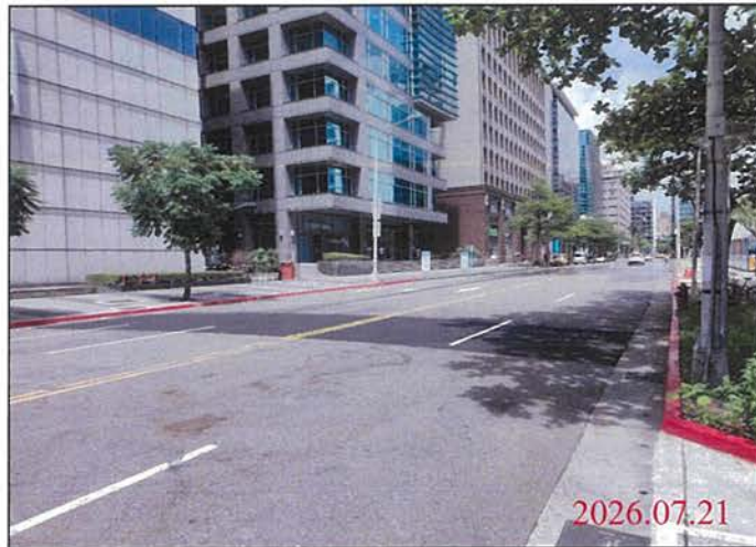
巡查日期地點：115.07.21 Y31車站 照片說明：路面狀況
