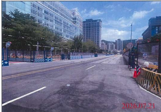
巡查日期地點：115.07.21 尾軌 照片說明：路面狀況
