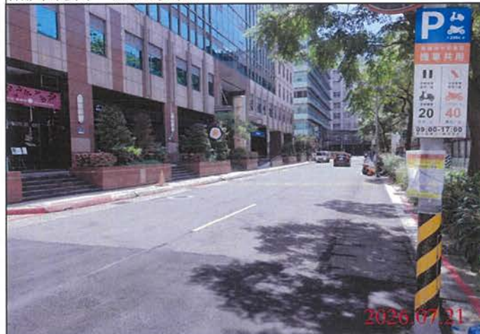
巡查日期地點：115.07.21 Y31車站 照片說明：路面狀況
