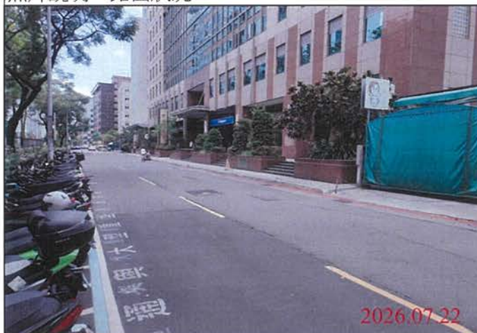
巡查日期地點：115.07.22 Y31車站 照片說明：路面狀況
