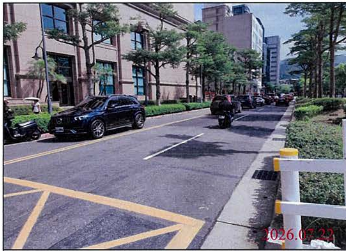
巡查日期地點：115.07.22 Y32車站 照片說明：路面狀況
