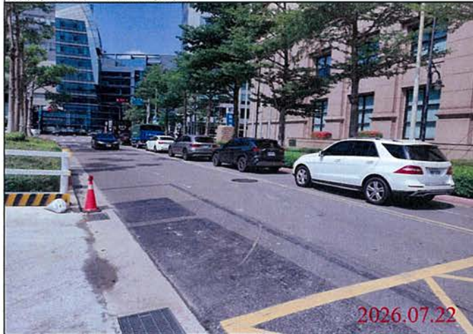
巡查日期地點：115.07.22 Y32車站 照片說明：路面狀況
