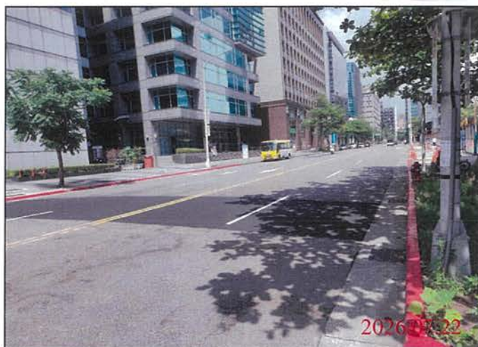
巡查日期地點：115.07.22 Y31車站 照片說明：路面狀況
