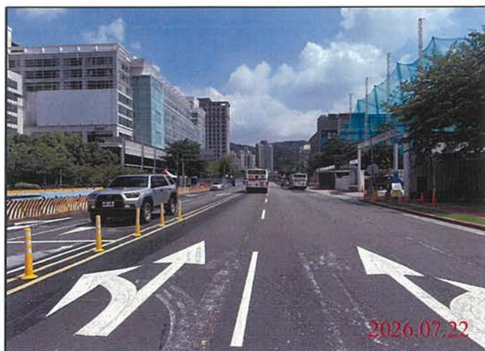
巡查日期地點：115.07.22 尾軌 照片說明：路面狀況
