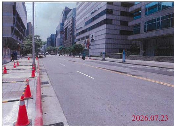
巡查日期地點：115.07.23 Y31車站 照片說明：路面狀況
