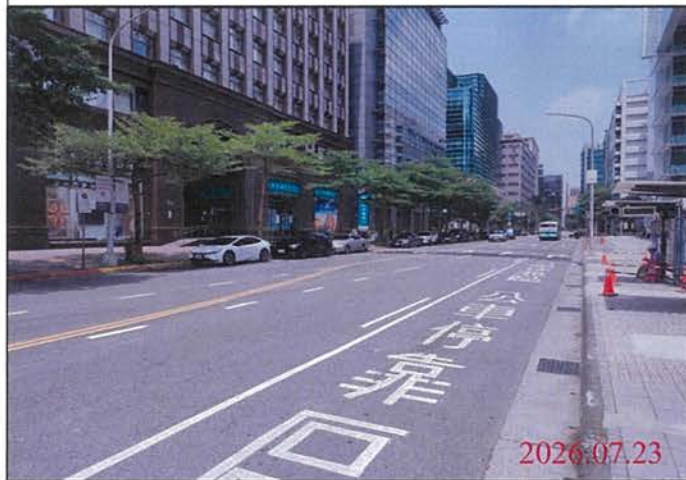
巡查日期地點：115.07.23 Y31車站 照片說明：路面狀況
