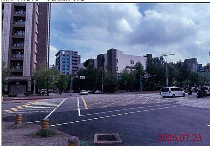
巡查日期地點：115.07.23 Y30車站 照片說明：路面狀況
