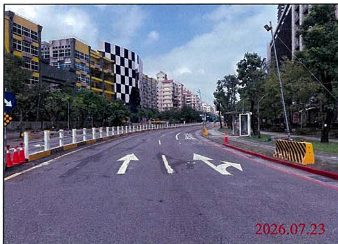
巡查日期地點：115.07.23 Y30車站 照片說明：路面狀況
