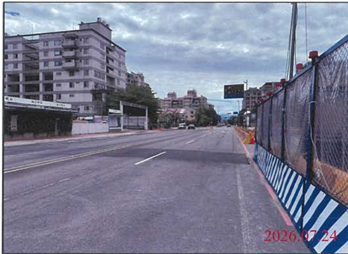
巡查日期地點：115.07.24 尾軌 照片說明：路面狀況
