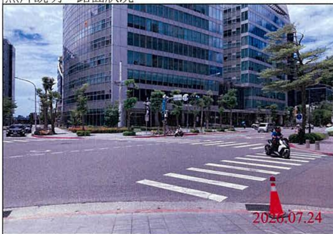
巡查日期地點：115.07.24 Y32車站 照片說明：路面狀況
