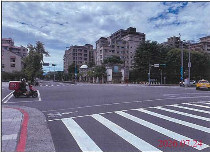
巡查日期地點：115.07.24 尾軌 照片說明：路面狀況
