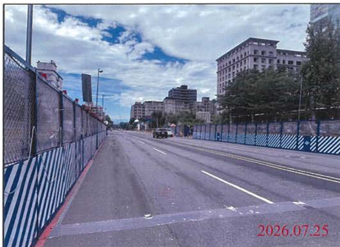
巡查日期地點：115.07.25 尾軌 照片說明：路面狀況
