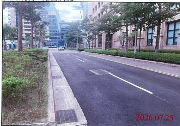
巡查日期地點：115.07.25 Y32車站 照片說明：路面狀況
