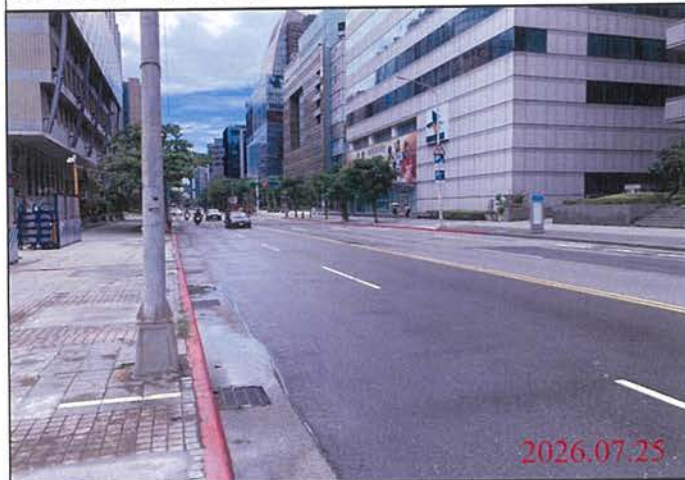
巡查日期地點：115.07.25 Y31車站 照片說明：路面狀況
