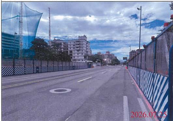
巡查日期地點：115.07.25 尾軌 照片說明：路面狀況
