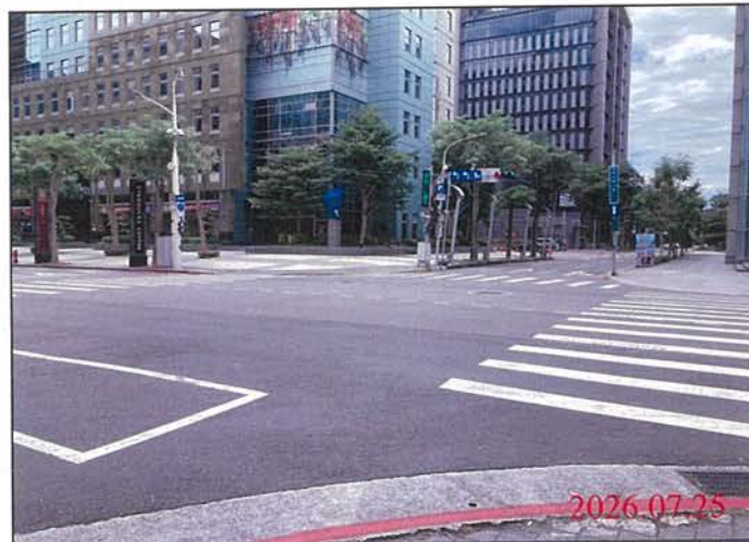
巡查日期地點：115.07.25 Y31車站 照片說明：路面狀況
