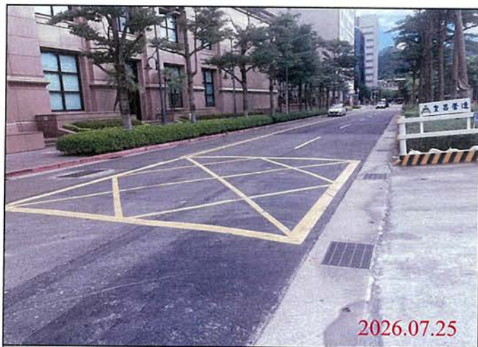
巡查日期地點：115.07.25 Y32車站 照片說明：路面狀況
