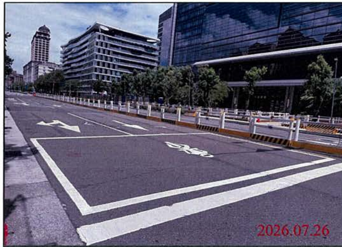
巡查日期地點：115.07.26 Y30車站 照片說明：路面狀況
