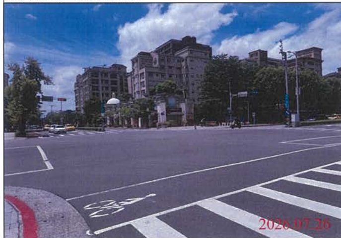
巡查日期地點：115.07.26 尾軌 照片說明：路面狀況
