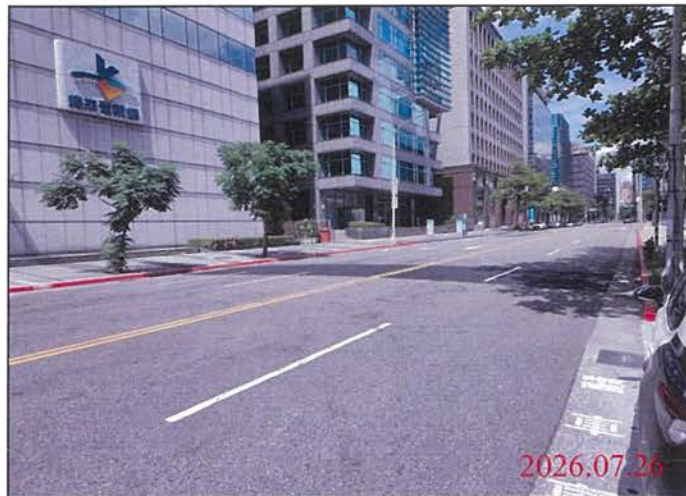
巡查日期地點：115.07.26 Y31車站 照片說明：路面狀況
