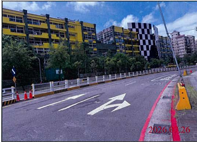
巡查日期地點：115.07.26 Y30車站 照片說明：路面狀況
