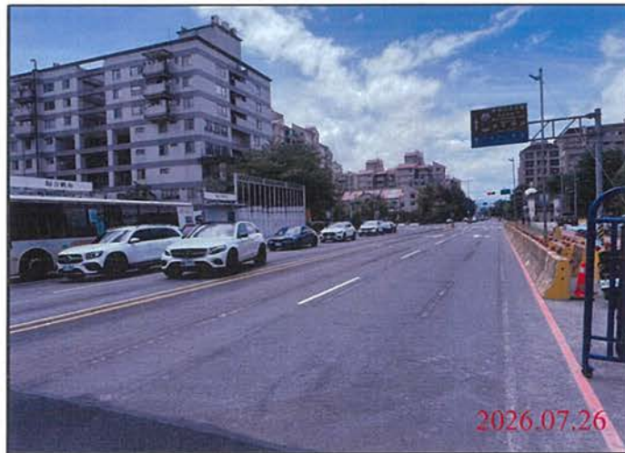
巡查日期地點：115.07.26 尾軌 照片說明：路面狀況
