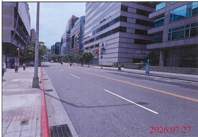
巡查日期地點：115.07.27 Y31車站 照片說明：路面狀況
