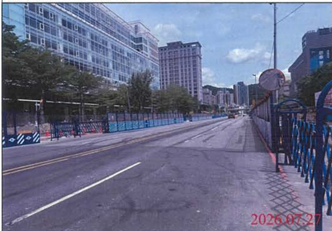
巡查日期地點：115.07.27 尾軌 照片說明：路面狀況
