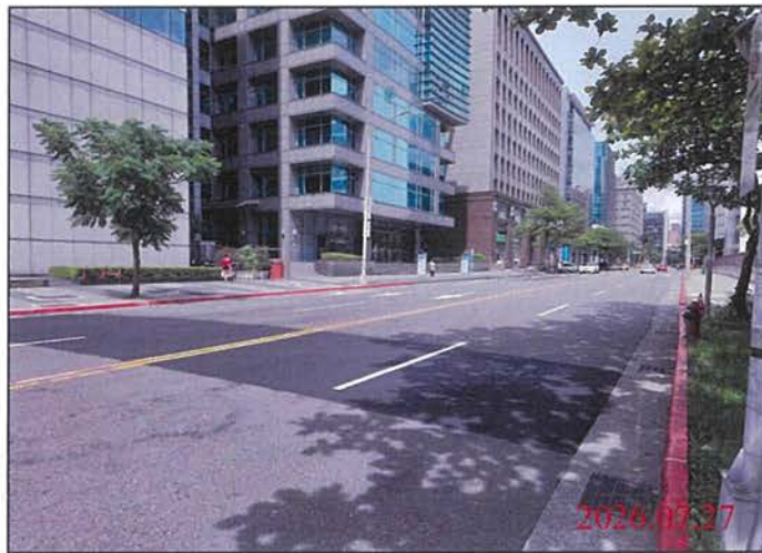
巡查日期地點：115.07.27 Y31車站 照片說明：路面狀況
