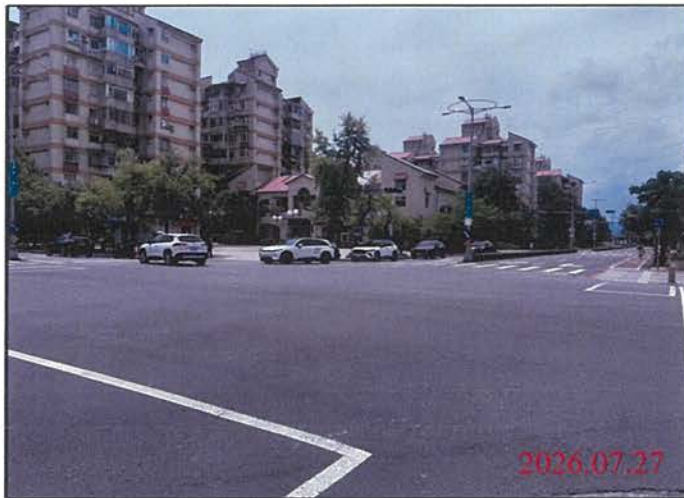
巡查日期地點：115.07.27 尾軌 照片說明：路面狀況
