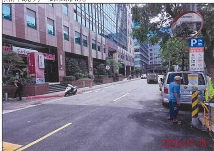
巡查日期地點：115.07.28 Y31車站 照片說明：路面狀況
