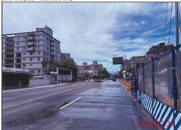
巡查日期地點：115.07.28 尾軌 照片說明：路面狀況
