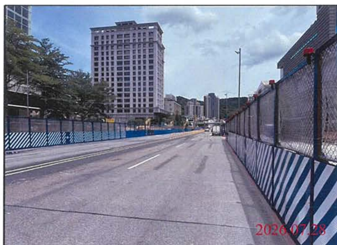
巡查日期地點：115.07.28 尾軌 照片說明：路面狀況
