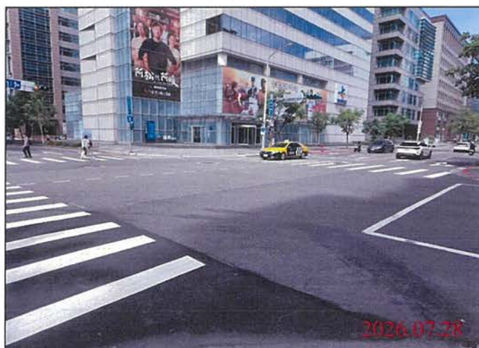
巡查日期地點：115.07.28 Y31車站 照片說明：路面狀況
