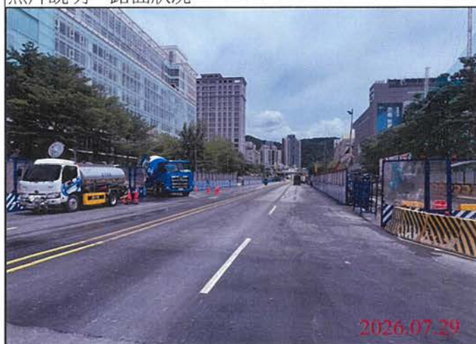
巡查日期地點：115.07.29 尾軌 照片說明：路面狀況
