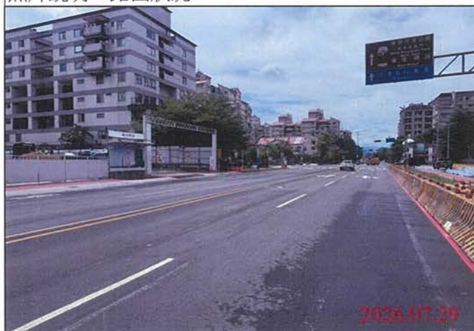
巡查日期地點：115.07.29 尾軌 照片說明：路面狀況
