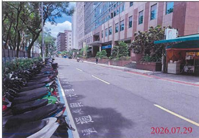
巡查日期地點：115.07.29 Y31車站 照片說明：路面狀況
