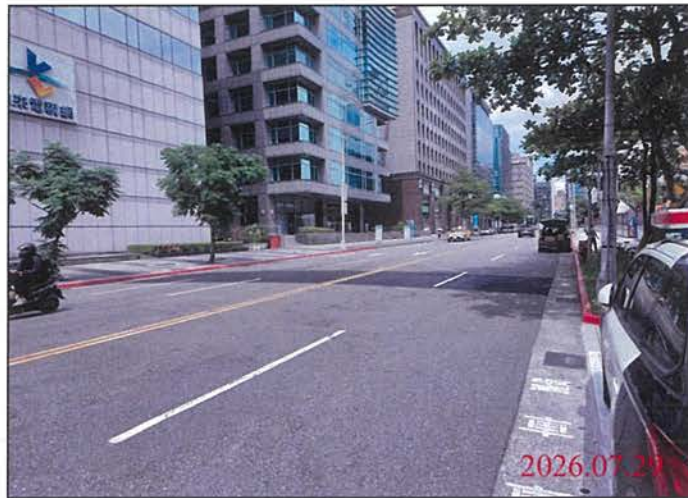
巡查日期地點：115.07.29 Y31車站 照片說明：路面狀況
