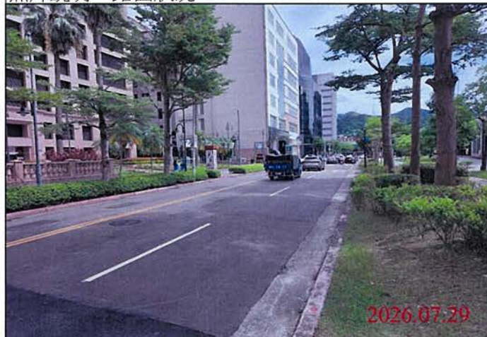
巡查日期地點：115.07.29 Y32車站 照片說明：路面狀況
