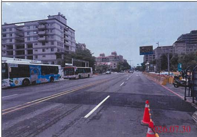
巡查日期地點：115.07.30 尾軌 照片說明：路面狀況
