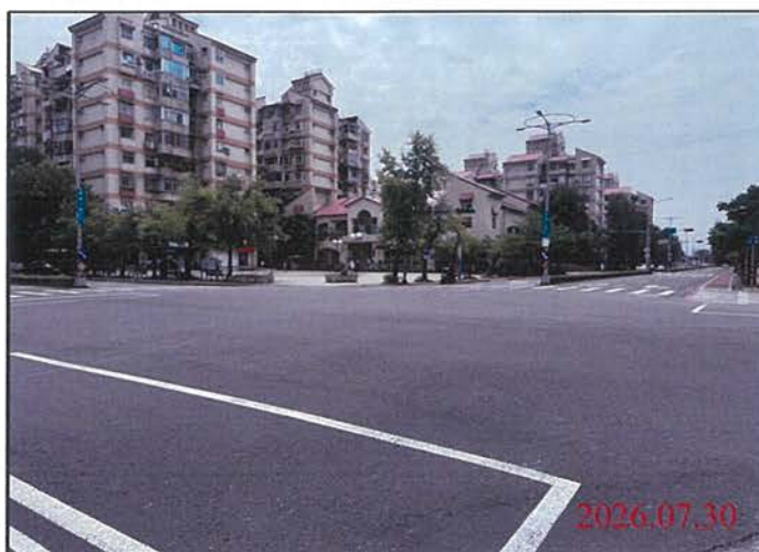
巡查日期地點：115.07.30 尾軌 照片說明：路面狀況
