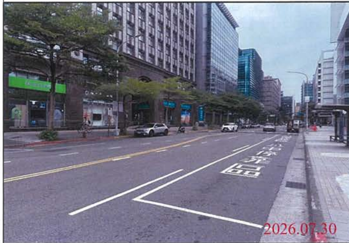
巡查日期地點：115.07.30 Y31車站 照片說明：路面狀況
