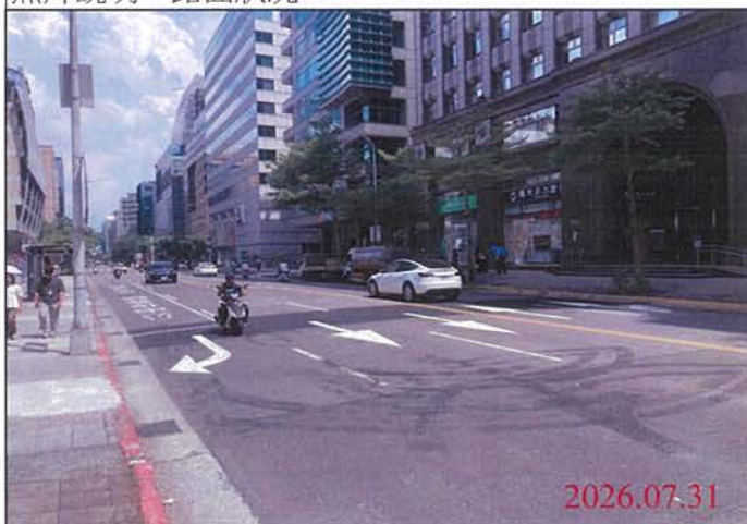
巡查日期地點：115.07.31 Y31車站 照片說明：路面狀況
