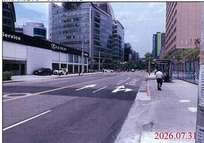
巡查日期地點：115.07.31 Y32車站 照片說明：路面狀況
