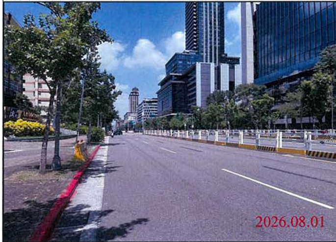
巡查日期地點：115.08.01 Y30車站 照片說明：路面狀況
