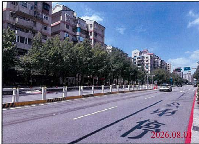
巡查日期地點：115.08.01 Y30車站 照片說明：路面狀況
