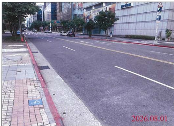
巡查日期地點：115.08.01 Y31車站 照片說明：路面狀況
