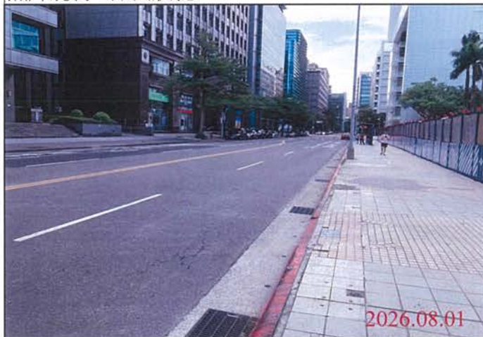
巡查日期地點：115.08.01 Y31車站 照片說明：路面狀況
