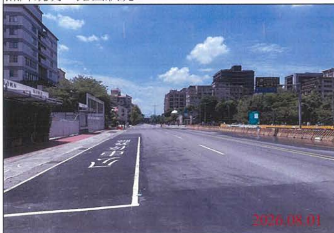
巡查日期地點：115.08.01 尾軌 照片說明：路面狀況
