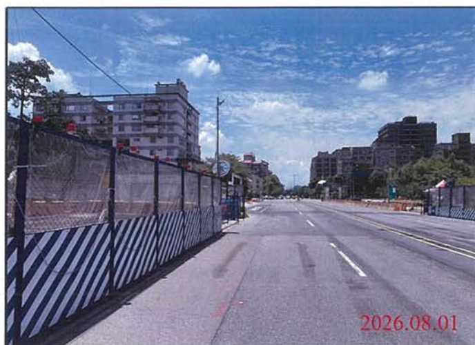
巡查日期地點：115.08.01 尾軌 照片說明：路面狀況
