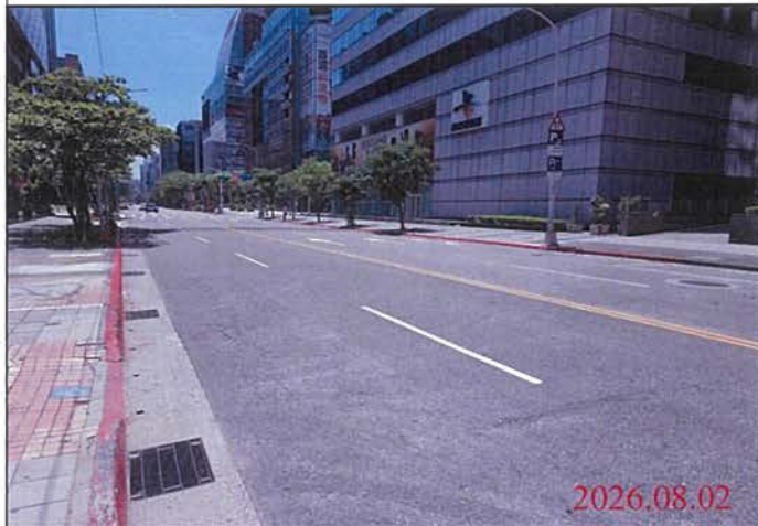
巡查日期地點：115.08.02 Y31車站 照片說明：路面狀況
