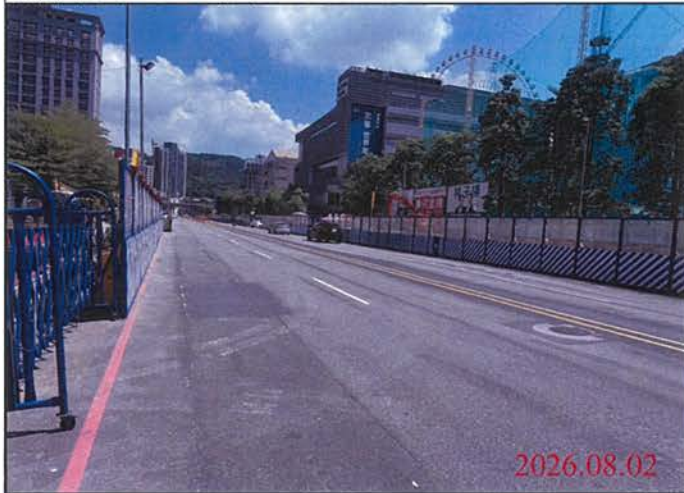
巡查日期地點：115.08.02 尾軌 照片說明：路面狀況
