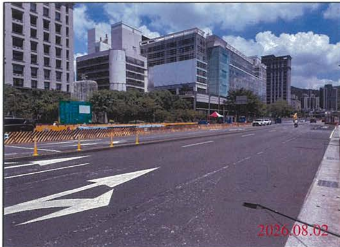
巡查日期地點：115.08.02 尾軌 照片說明：路面狀況
