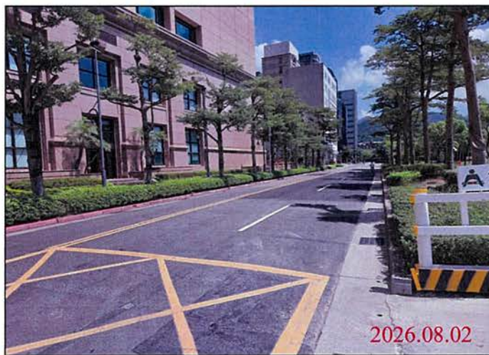
巡查日期地點：115.08.02 Y32車站 照片說明：路面狀況
