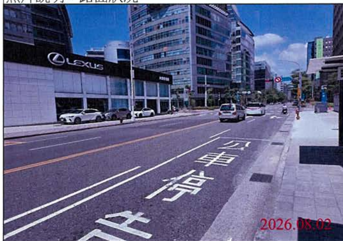
巡查日期地點：115.08.02 Y32車站 照片說明：路面狀況
