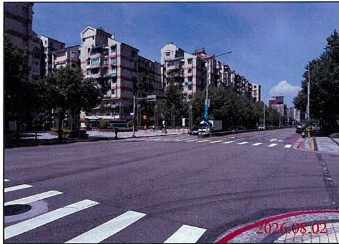
巡查日期地點：115.08.02 Y30車站 照片說明：路面狀況
