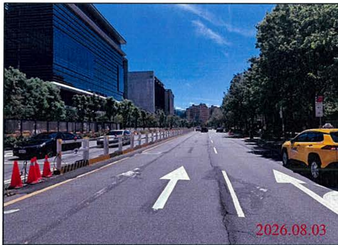
巡查日期地點：115.08.03 Y30車站 照片說明：路面狀況
