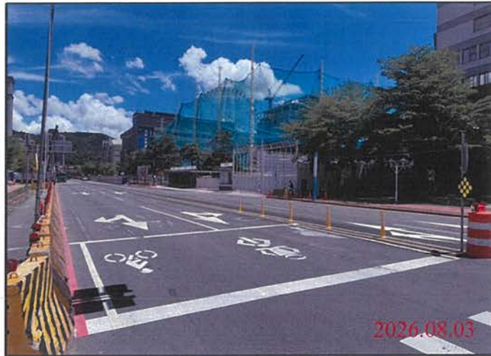
巡查日期地點：115.08.03 尾軌 照片說明：路面狀況
