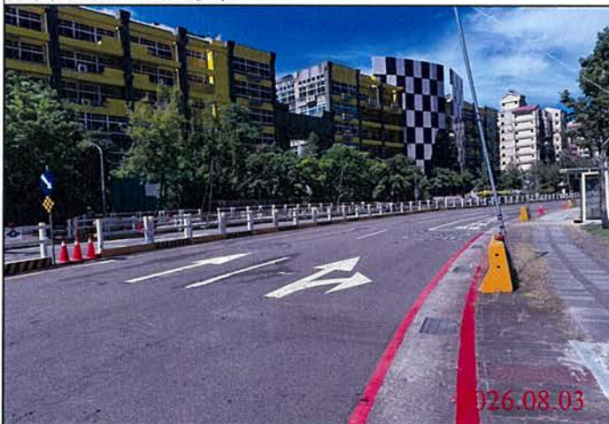
巡查日期地點：115.08.03 Y30車站 照片說明：路面狀況
