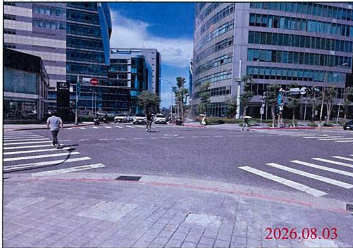
巡查日期地點：115.08.03 Y32車站 照片說明：路面狀況
