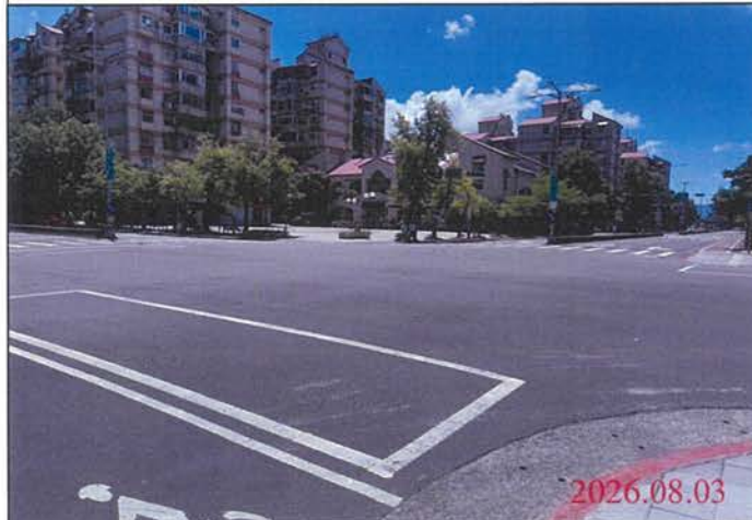
巡查日期地點：115.08.03 尾軌 照片說明：路面狀況
