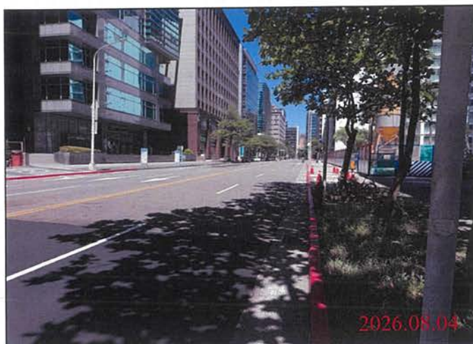
巡查日期地點：115.08.04 Y31車站 照片說明：路面狀況
