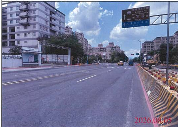
巡查日期地點：115.08.05 尾軌 照片說明：路面狀況
