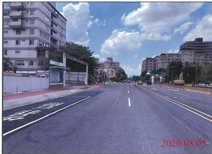
巡查日期地點：115.08.05 尾軌 照片說明：路面狀況
