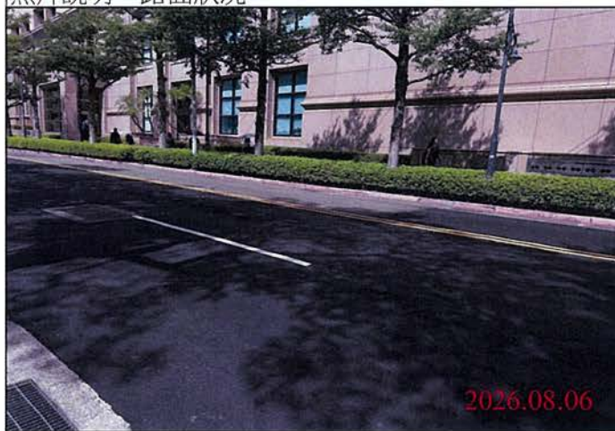
巡查日期地點：115.08.06 Y32車站 照片說明：路面狀況
