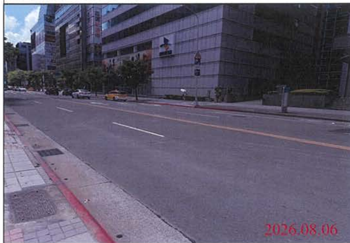
巡查日期地點：115.08.06 Y31車站 照片說明：路面狀況
