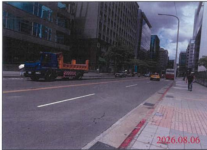
巡查日期地點：115.08.06 Y31車站 照片說明：路面狀況
