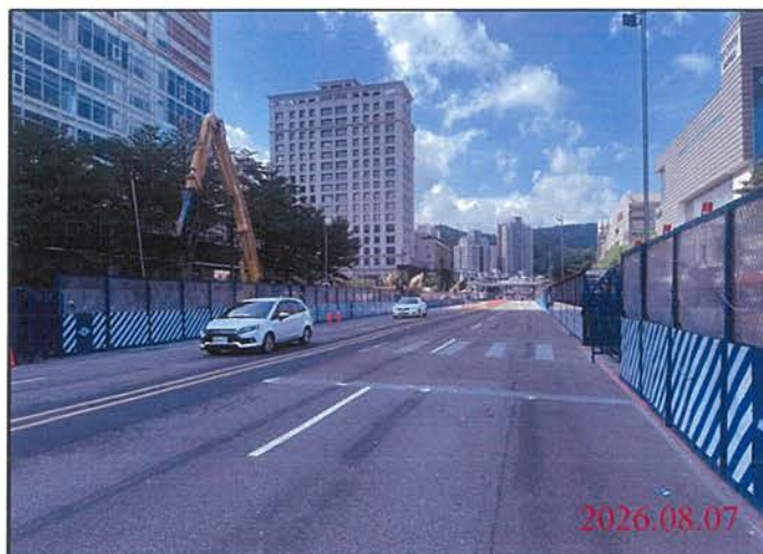
巡查日期地點：115.08.07 尾軌 照片說明：路面狀況
