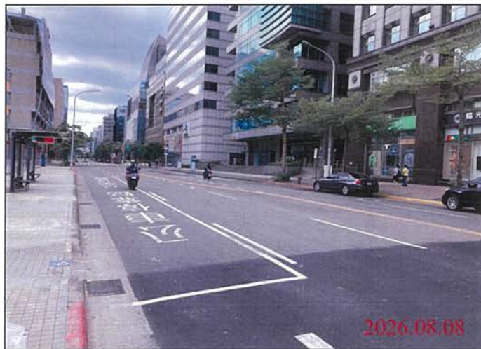
巡查日期地點：115.08.08 Y31車站 照片說明：路面狀況
