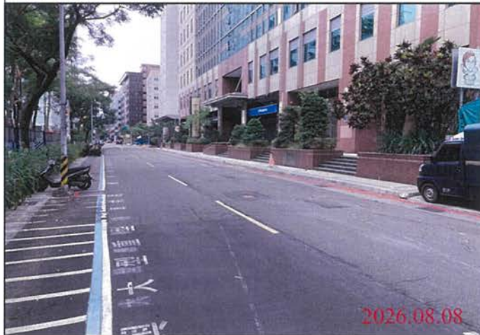
巡查日期地點：115.08.08 Y31車站 照片說明：路面狀況
