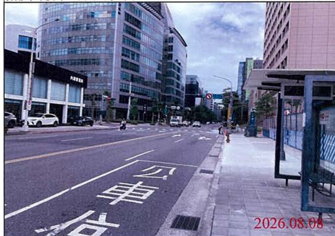
巡查日期地點：115.08.08 Y32車站 照片說明：路面狀況
