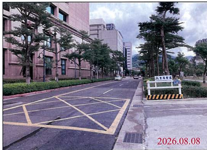
巡查日期地點：115.08.08 Y32車站 照片說明：路面狀況
