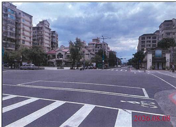
巡查日期地點：115.08.08 尾軌 照片說明：路面狀況
