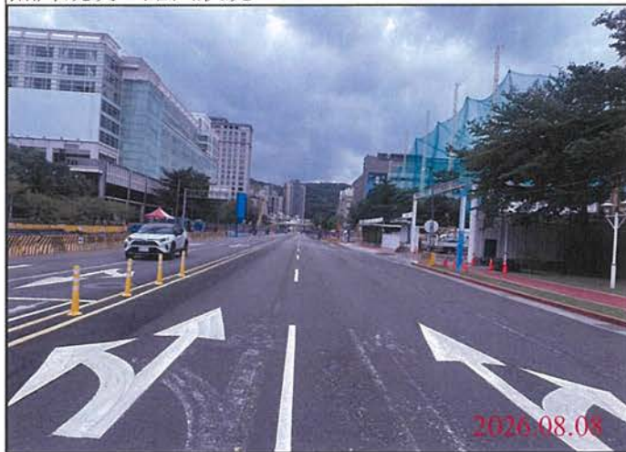
巡查日期地點：115.08.08 尾軌 照片說明：路面狀況
