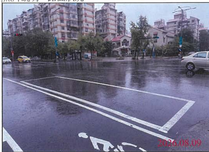
巡查日期地點：115.08.09 尾軌 照片說明：路面狀況
