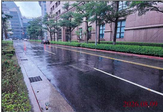
巡查日期地點：115.08.09 Y32車站 照片說明：路面狀況
