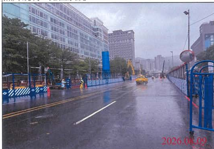
巡查日期地點：115.08.09 尾軌 照片說明：路面狀況
