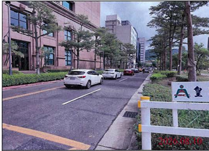
巡查日期地點：115.08.10 Y32車站 照片說明：路面狀況
