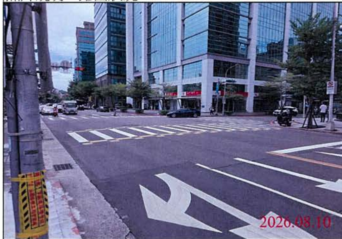
巡查日期地點：115.08.10 Y32車站 照片說明：路面狀況
