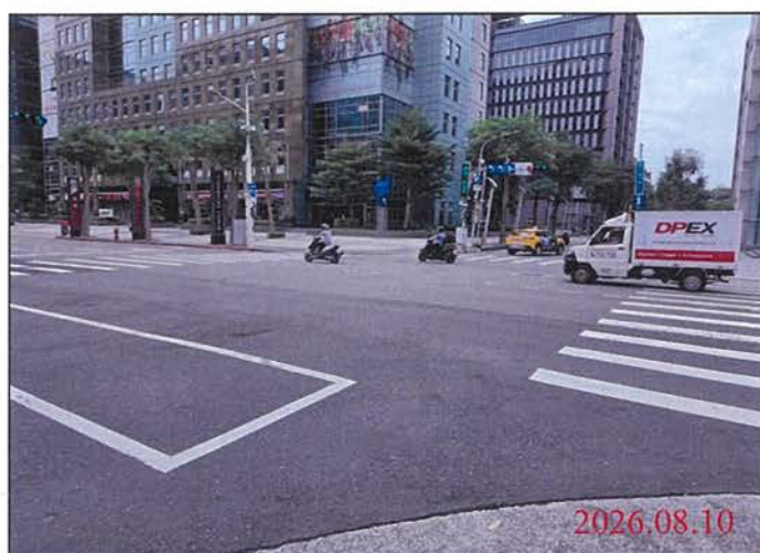
巡查日期地點：115.08.10 Y31車站 照片說明：路面狀況
