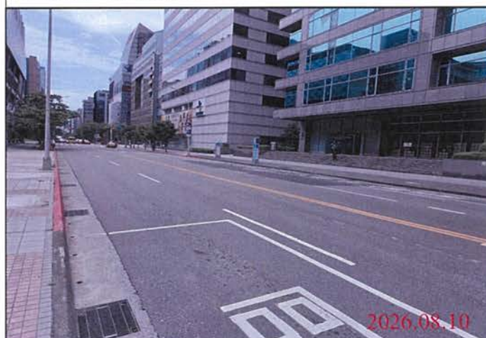
巡查日期地點：115.08.10 Y31車站 照片說明：路面狀況
