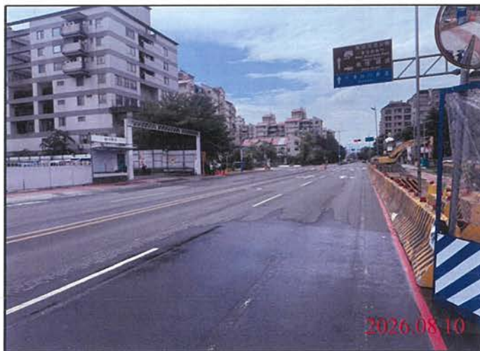
巡查日期地點：115.08.10 尾軌 照片說明：路面狀況
