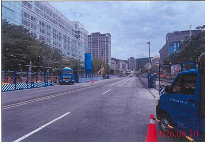
巡查日期地點：115.08.10 尾軌 照片說明：路面狀況
