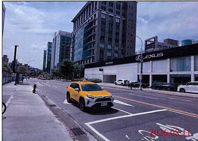
巡查日期地點：115.08.11 Y32車站 照片說明：路面狀況
