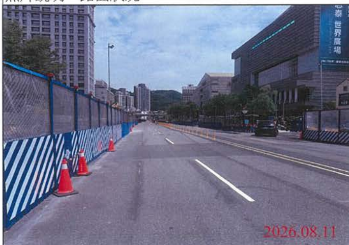
巡查日期地點：115.08.11 尾軌 照片說明：路面狀況
