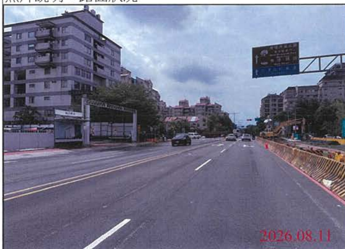
巡查日期地點：115.08.11 尾軌 照片說明：路面狀況
