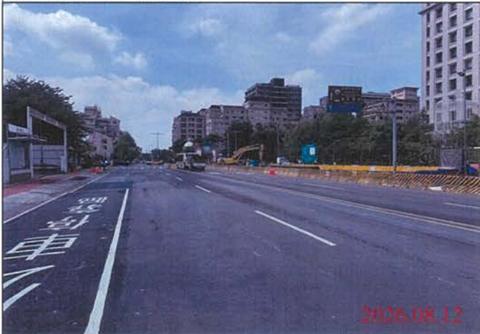
巡查日期地點：115.08.12 尾軌 照片說明：路面狀況
