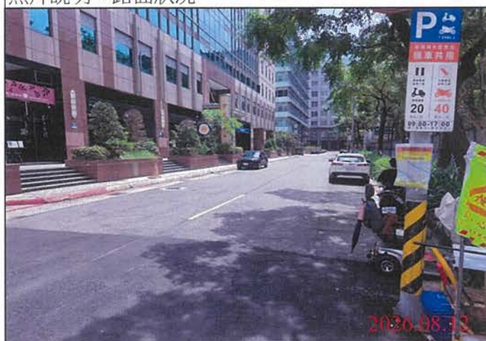
巡查日期地點：115.08.12 Y31車站 照片說明：路面狀況
