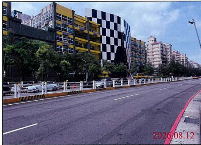
巡查日期地點：115.08.12 Y30車站 照片說明：路面狀況
