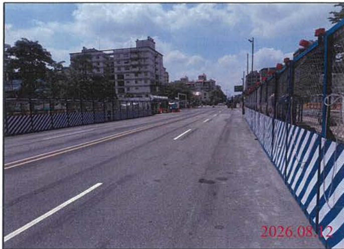
巡查日期地點：115.08.12 尾軌 照片說明：路面狀況
