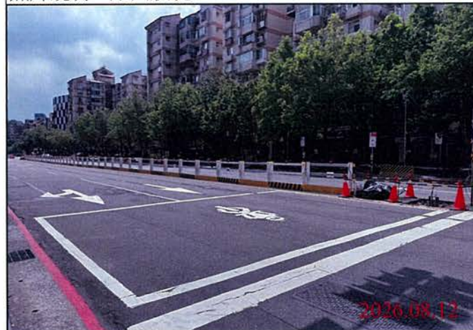
巡查日期地點：115.08.12 Y30車站 照片說明：路面狀況
