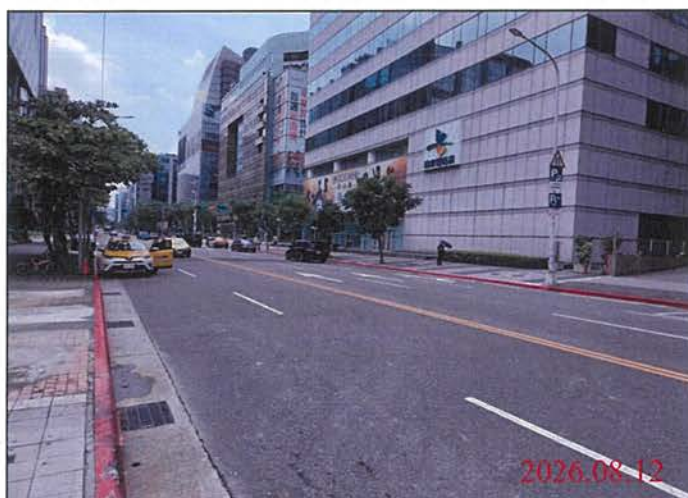
巡查日期地點：115.08.12 Y31車站 照片說明：路面狀況
