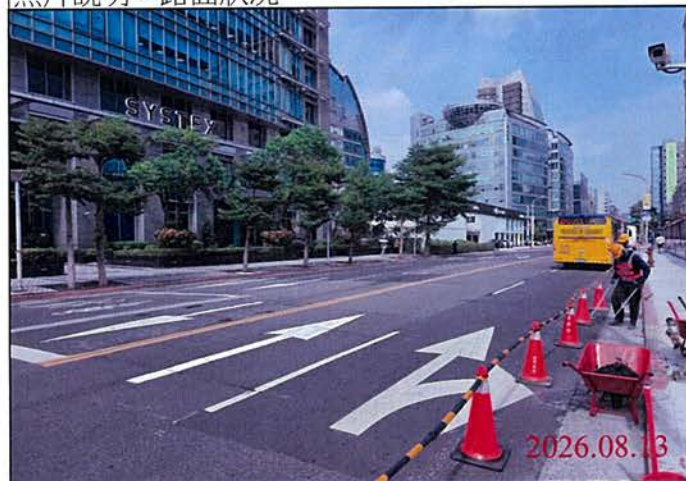
巡查日期地點：115.08.13 Y32車站 照片說明：路面狀況
