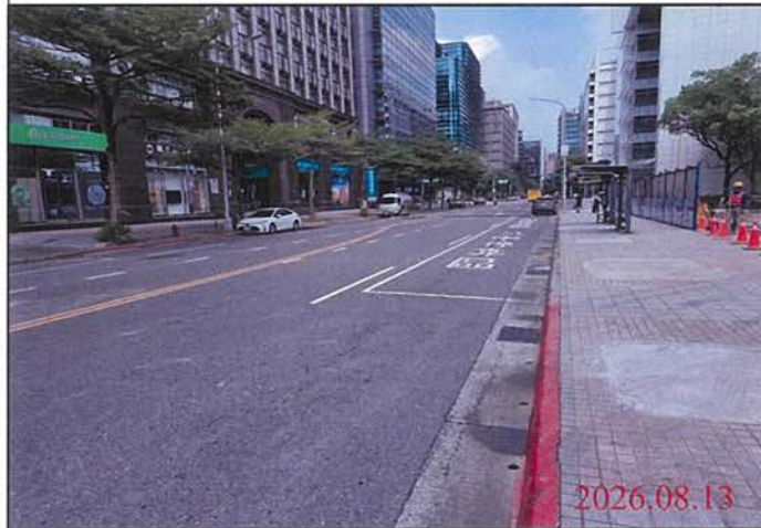
巡查日期地點：115.08.13 Y31車站 照片說明：路面狀況
