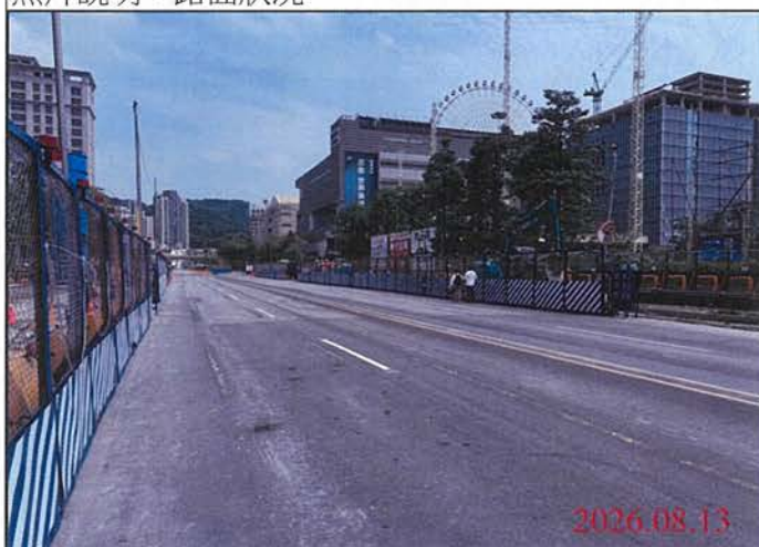
巡查日期地點：115.08.13 尾軌 照片說明：路面狀況
