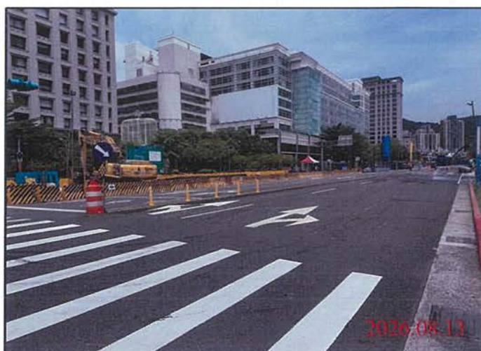
巡查日期地點：115.08.13 尾軌 照片說明：路面狀況
