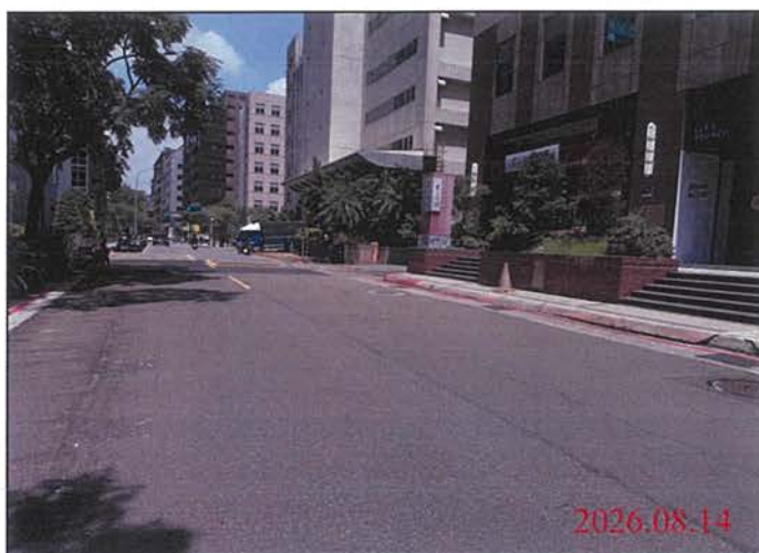
巡查日期地點：115.08.14 Y31車站 照片說明：路面狀況
