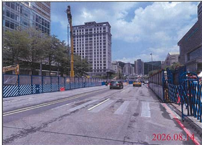
巡查日期地點：115.08.14 尾軌 照片說明：路面狀況
