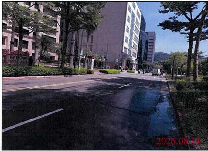
巡查日期地點：115.08.14 Y32車站 照片說明：路面狀況
