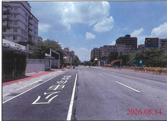
巡查日期地點：115.08.14 尾軌 照片說明：路面狀況
