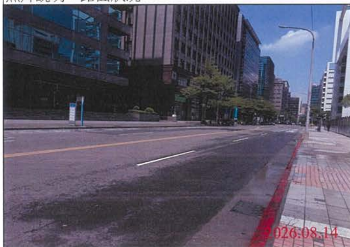
巡查日期地點：115.08.14 Y31車站 照片說明：路面狀況
