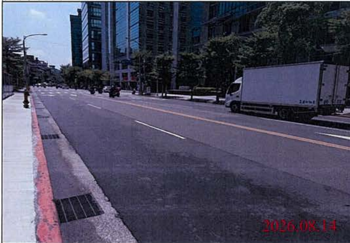
巡查日期地點：115.08.14 Y32車站 照片說明：路面狀況
