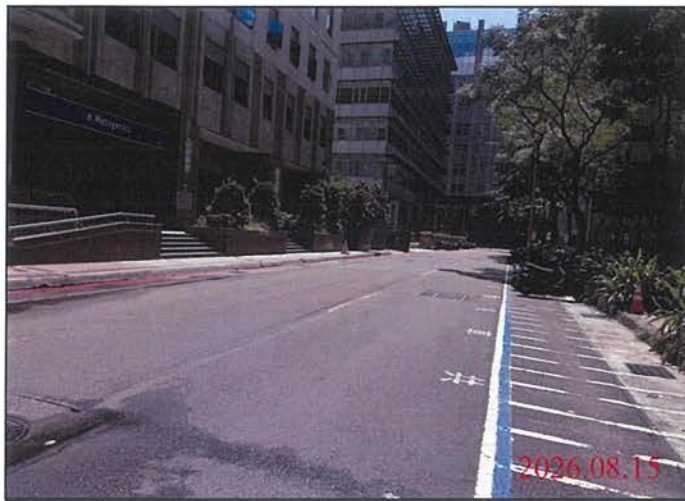
巡查日期地點：115.08.15 Y31車站 照片說明：路面狀況
