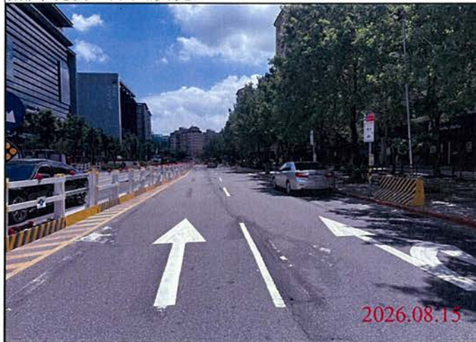
巡查日期地點：115.08.15 Y30車站 照片說明：路面狀況
