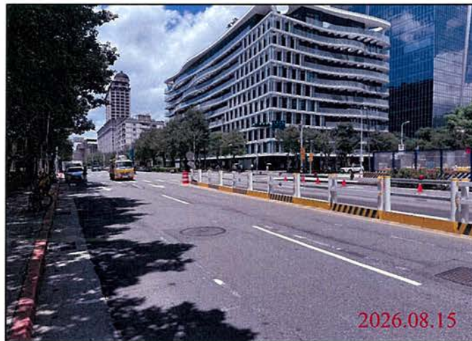
巡查日期地點：115.08.15 Y30車站 照片說明：路面狀況
