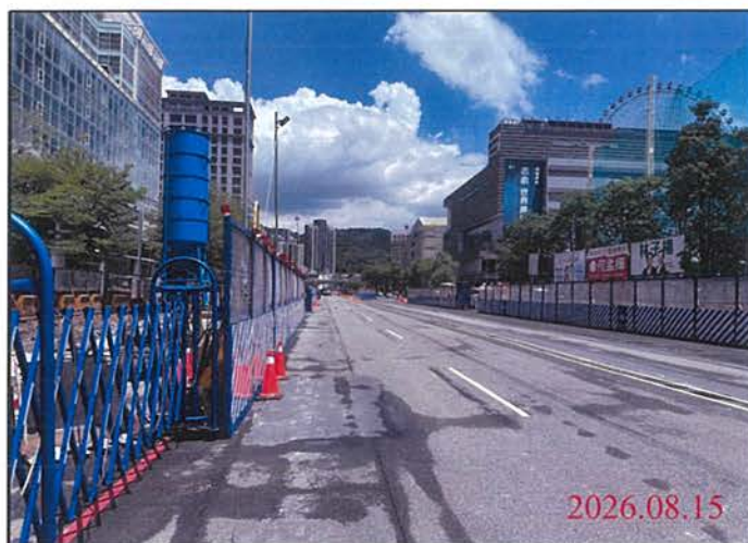
巡查日期地點：115.08.15 尾軌 照片說明：路面狀況
