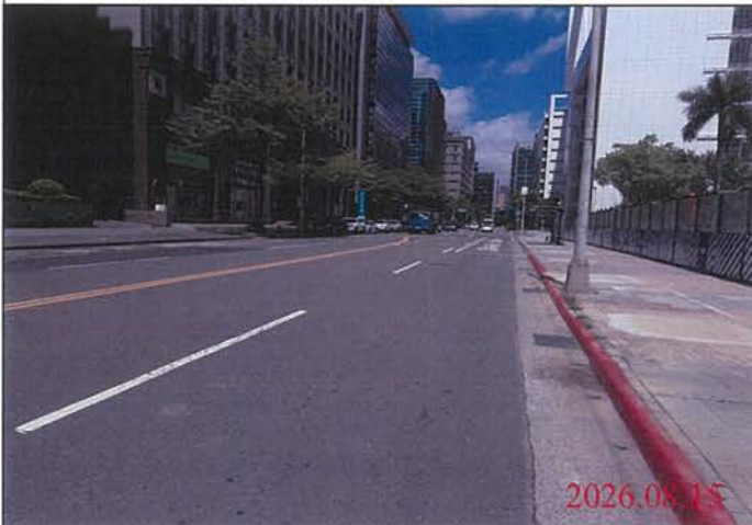
巡查日期地點：115.08.15 Y31車站 照片說明：路面狀況
