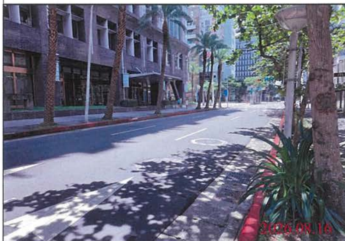
巡查日期地點：115.08.16 Y31車站 照片說明：路面狀況
