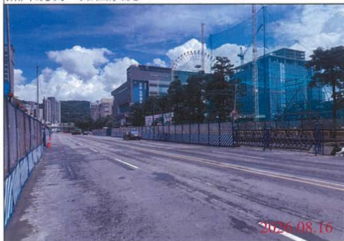
巡查日期地點：115.08.16 尾軌 照片說明：路面狀況
