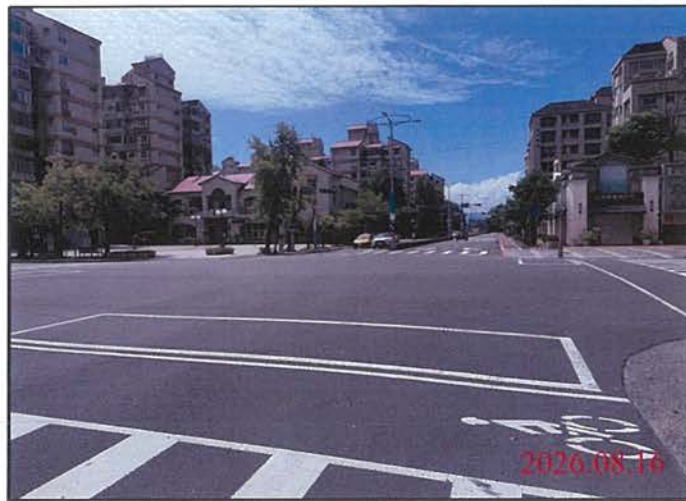
巡查日期地點：115.08.16 尾軌 照片說明：路面狀況
