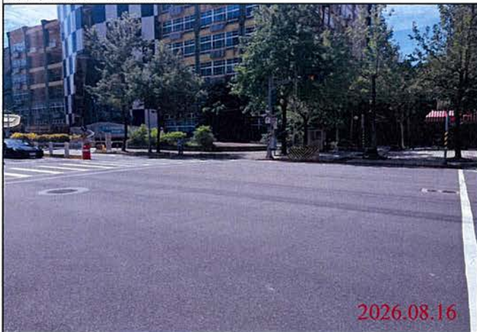
巡查日期地點：115.08.16 Y30車站 照片說明：路面狀況
