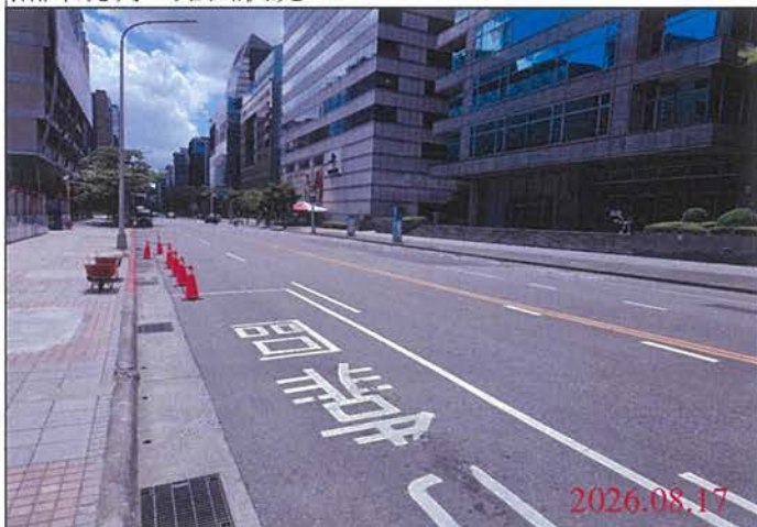
巡查日期地點：115.08.17 Y31車站 照片說明：路面狀況
