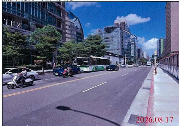
巡查日期地點：115.08.17 Y32車站 照片說明：路面狀況
