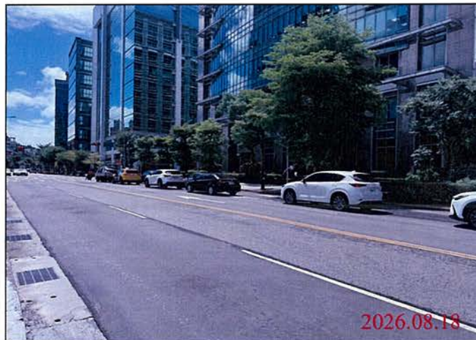
巡查日期地點：115.08.18 Y32車站 照片說明：路面狀況
