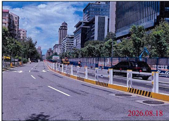
巡查日期地點：115.08.18 Y30車站 照片說明：路面狀況
