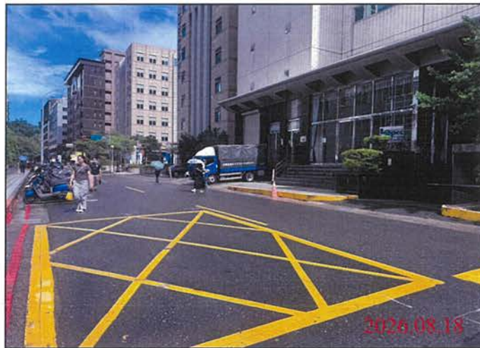
巡查日期地點：115.08.18 Y31車站 照片說明：路面狀況
