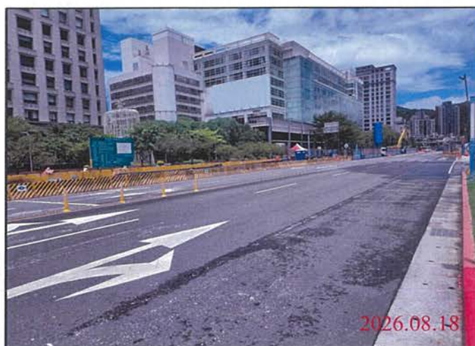
巡查日期地點：115.08.18 尾軌 照片說明：路面狀況
