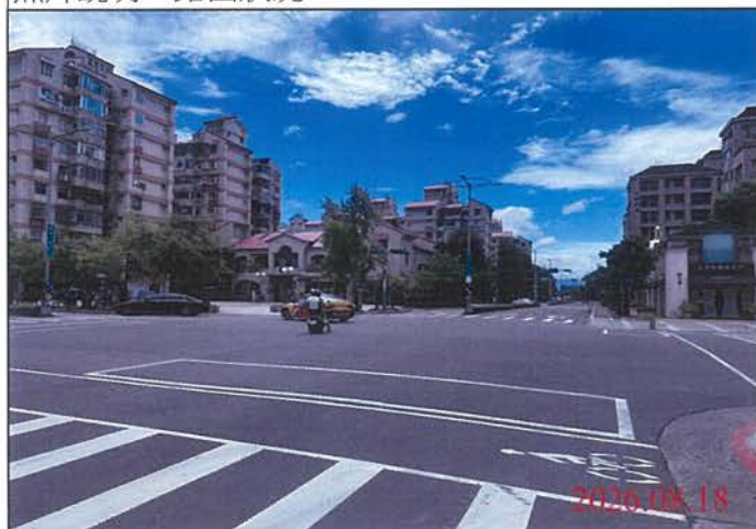
巡查日期地點：115.08.18 尾軌 照片說明：路面狀況
