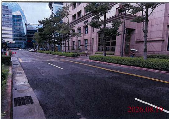
巡查日期地點：115.08.19 Y32車站 照片說明：路面狀況
