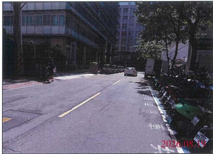
巡查日期地點：115.08.19 Y31車站 照片說明：路面狀況
