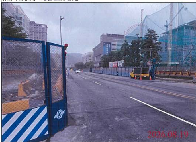
巡查日期地點：115.08.19 尾軌 照片說明：路面狀況
