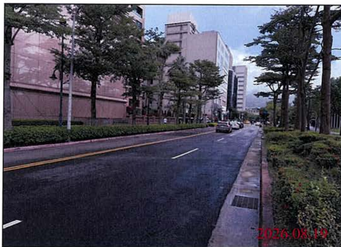
巡查日期地點：115.08.19 Y32車站 照片說明：路面狀況
