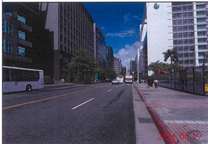
巡查日期地點：115.08.19 Y31車站 照片說明：路面狀況
