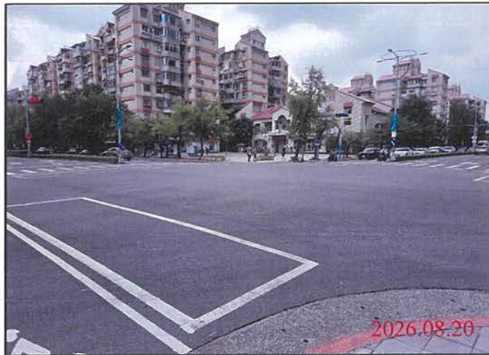
巡查日期地點：115.08.20 尾軌 照片說明：路面狀況
