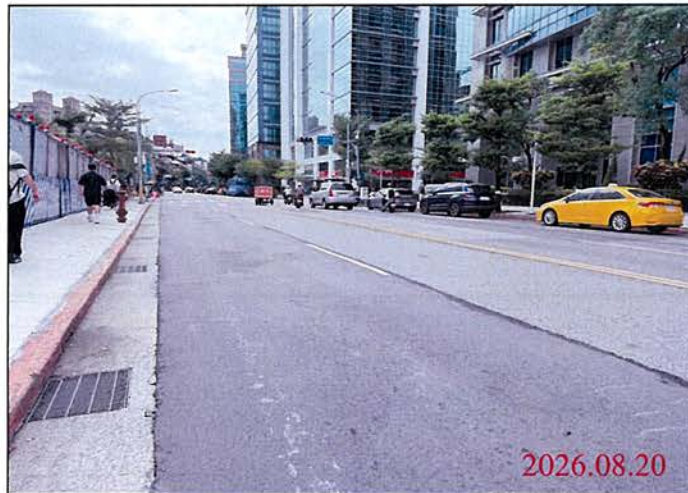
巡查日期地點：115.08.20 Y32車站 照片說明：路面狀況
