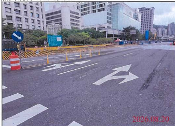
巡查日期地點：115.08.20 尾軌 照片說明：路面狀況
