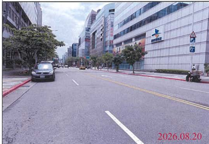
巡查日期地點：115.08.20 Y31車站 照片說明：路面狀況
