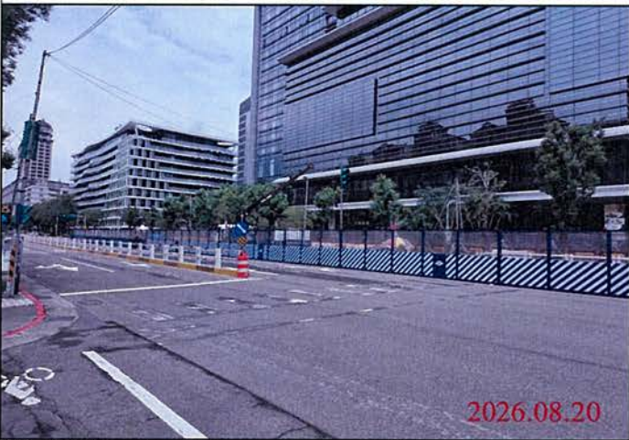
巡查日期地點：115.08.20 Y30車站 照片說明：路面狀況
