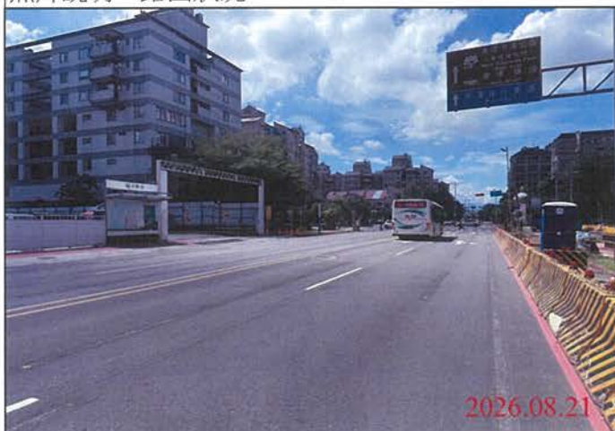
巡查日期地點：115.08.21 尾軌 照片說明：路面狀況
