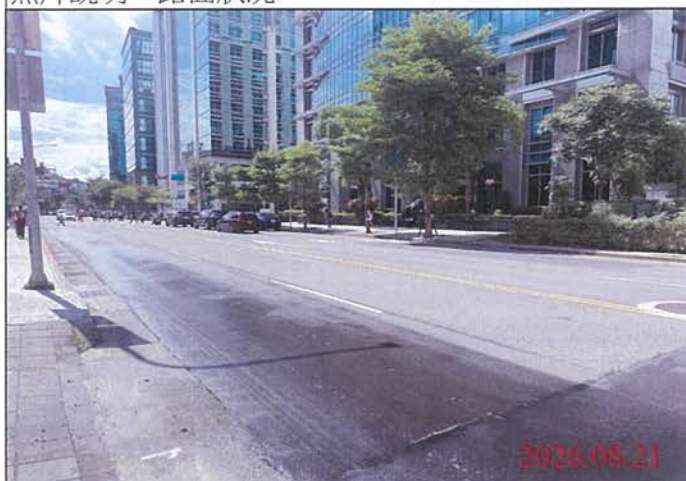
巡查日期地點：115.08.21 Y31車站 照片說明：路面狀況
