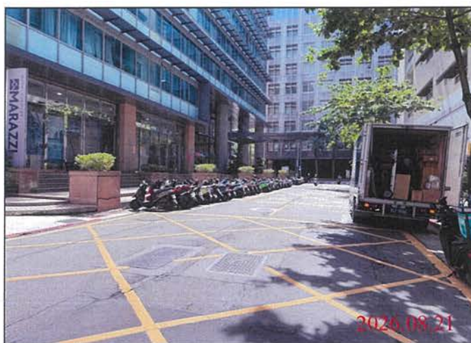
巡查日期地點：115.08.21 Y31車站 照片說明：路面狀況
