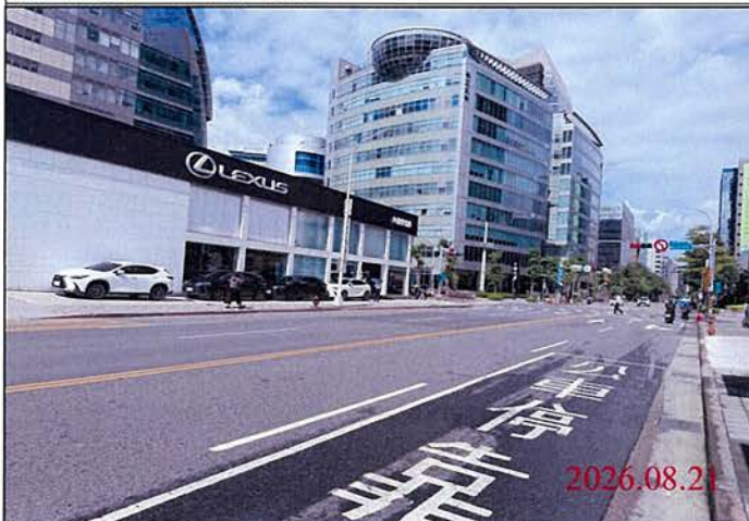
巡查日期地點：115.08.21 Y32車站 照片說明：路面狀況
