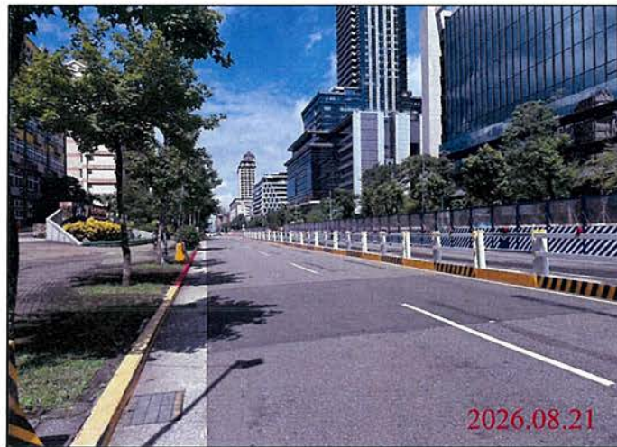
巡查日期地點：115.08.21 Y30車站 照片說明：路面狀況
