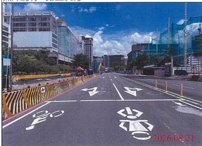
巡查日期地點：115.08.21 尾軌 照片說明：路面狀況
