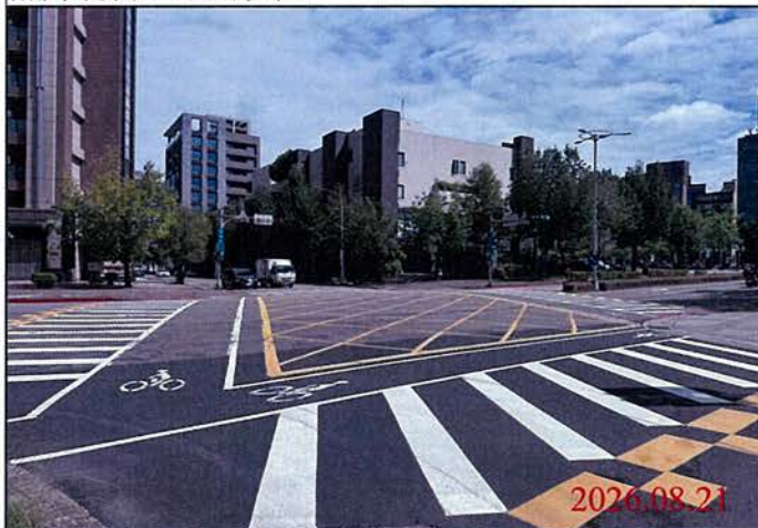
巡查日期地點：115.08.21 Y30車站 照片說明：路面狀況
