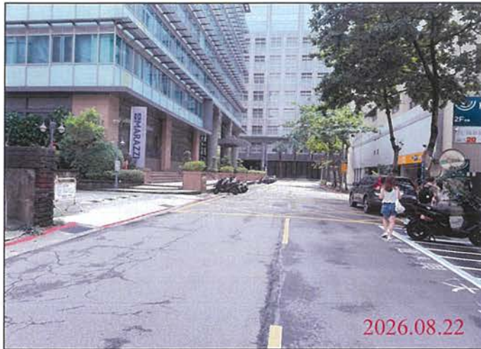
巡查日期地點：115.08.22 Y31車站 照片說明：路面狀況
