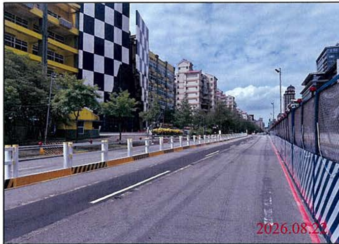
巡查日期地點：115.08.22 Y30車站 照片說明：路面狀況
