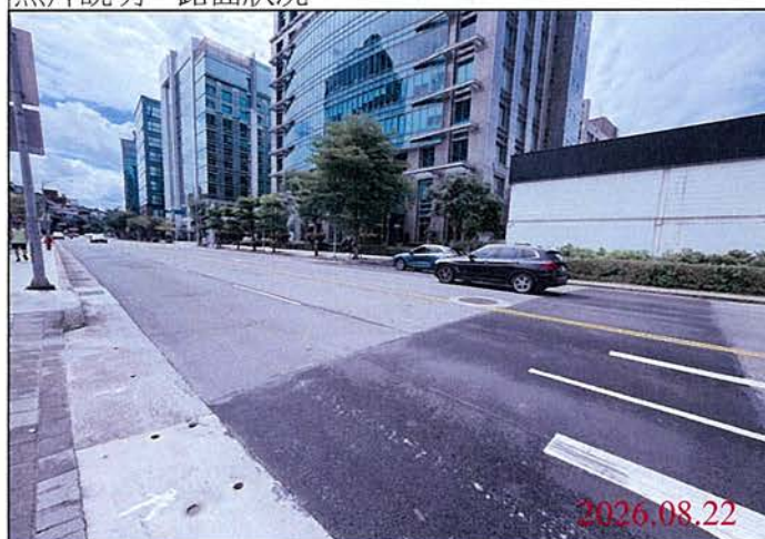
巡查日期地點：115.08.22 Y32車站 照片說明：路面狀況
