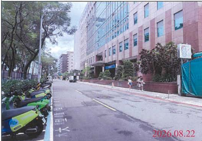
巡查日期地點：115.08.22 Y31車站 照片說明：路面狀況
