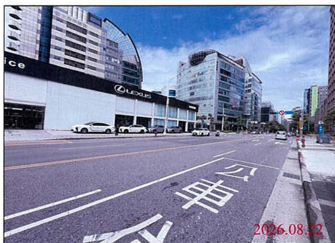
巡查日期地點：115.08.22 Y32車站 照片說明：路面狀況
