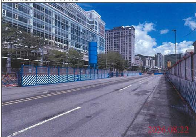
巡查日期地點：115.08.22 尾軌 照片說明：路面狀況
