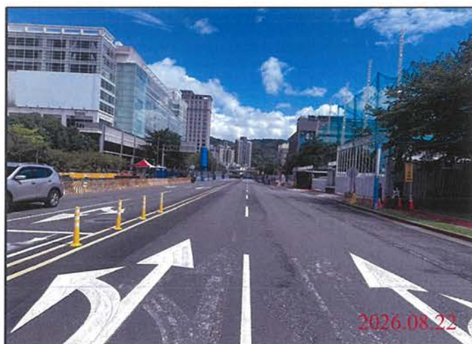
巡查日期地點：115.08.22 尾軌 照片說明：路面狀況
