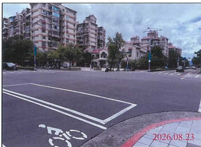
巡查日期地點：115.08.23 尾軌 照片說明：路面狀況
