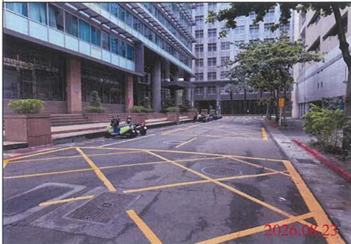
巡查日期地點：115.08.23 Y31車站 照片說明：路面狀況
