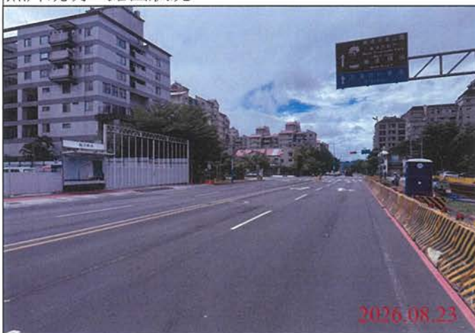
巡查日期地點：115.08.23 尾軌 照片說明：路面狀況
