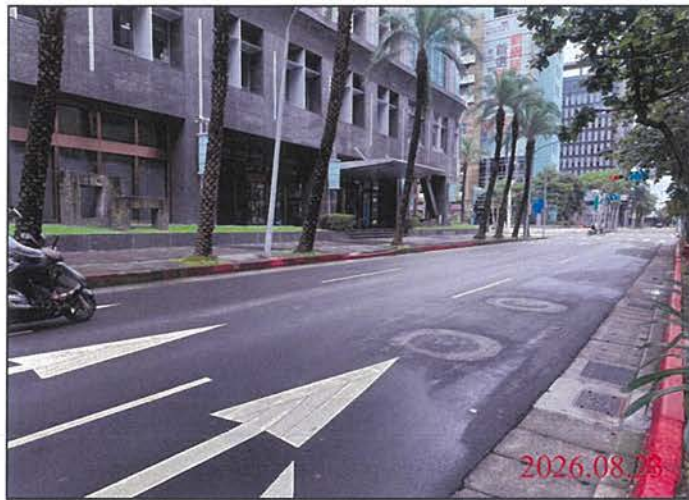
巡查日期地點：115.08.23 Y31車站 照片說明：路面狀況
