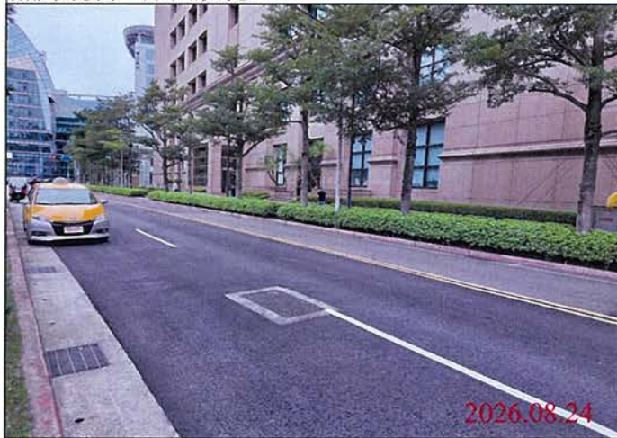
巡查日期地點：115.08.24 Y32車站 照片說明：路面狀況
