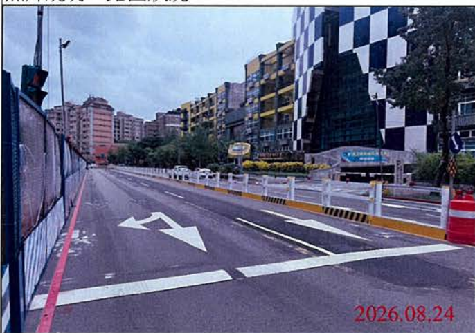
巡查日期地點：115.08.24 Y30車站 照片說明：路面狀況
