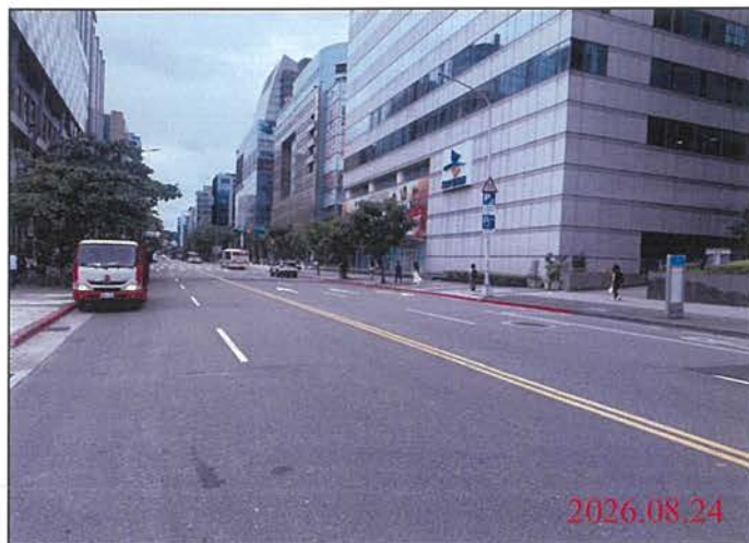
巡查日期地點：115.08.24 Y31車站 照片說明：路面狀況
