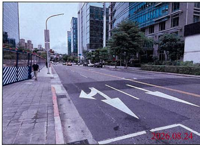
巡查日期地點：115.08.24 Y32車站 照片說明：路面狀況
