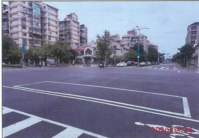
巡查日期地點：115.08.24 尾軌 照片說明：路面狀況
