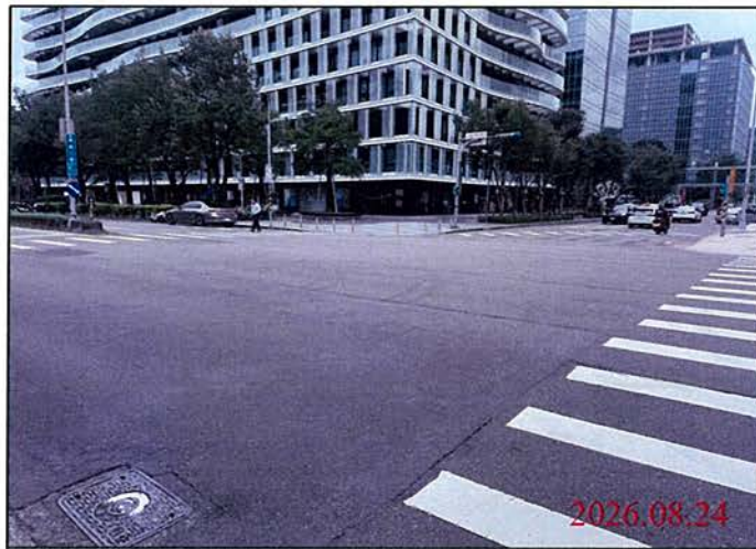
巡查日期地點：115.08.24 Y30車站 照片說明：路面狀況
