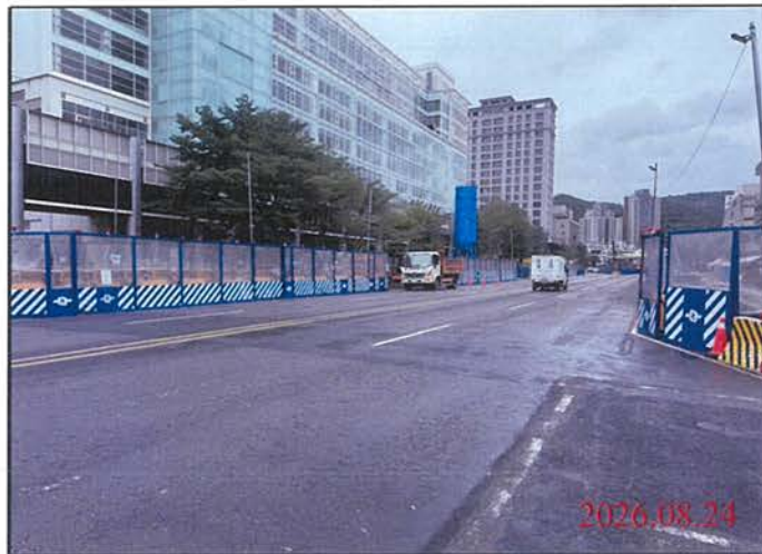
巡查日期地點：115.08.24 尾軌 照片說明：路面狀況
