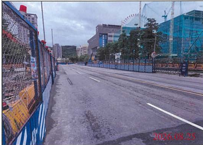
巡查日期地點：115.08.25 尾軌 照片說明：路面狀況
