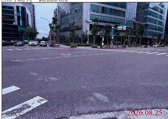
巡查日期地點：115.08.25 Y32車站 照片說明：路面狀況
