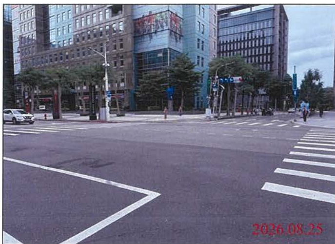
巡查日期地點：115.08.25 Y31車站 照片說明：路面狀況
