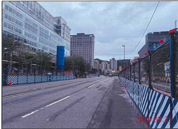
巡查日期地點：115.08.25 尾軌 照片說明：路面狀況
