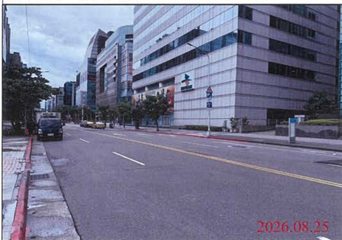
巡查日期地點：115.08.25 Y31車站 照片說明：路面狀況
