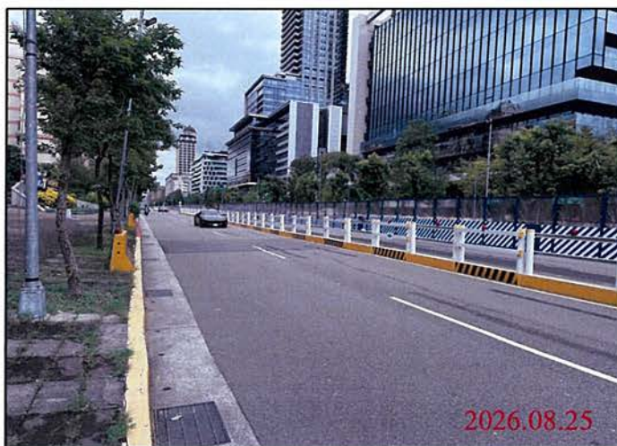
巡查日期地點：115.08.25 Y30車站 照片說明：路面狀況
