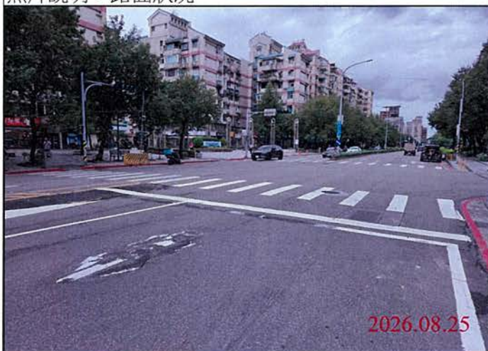
巡查日期地點：115.08.25 Y30車站 照片說明：路面狀況
