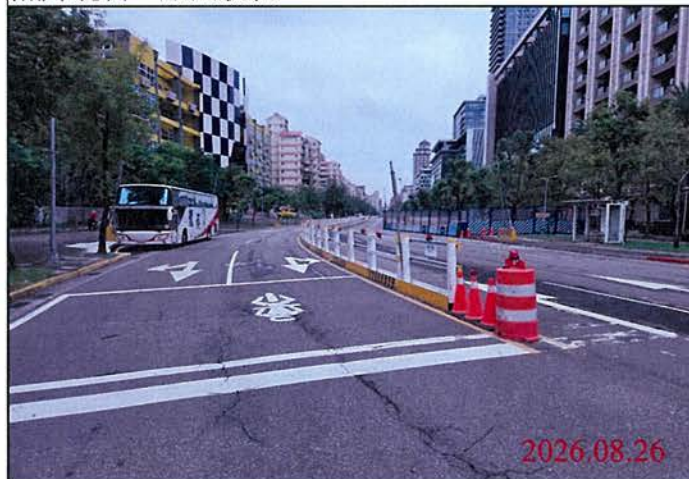
巡查日期地點：115.08.26 Y30車站 照片說明：路面狀況
