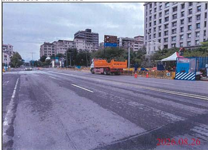
巡查日期地點：115.08.26 尾軌 照片說明：路面狀況
