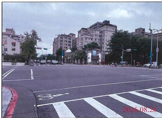
巡查日期地點：115.08.26 尾軌 照片說明：路面狀況
