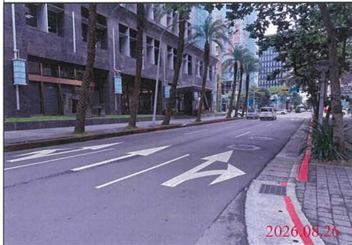
巡查日期地點：115.08.26 Y31車站 照片說明：路面狀況
