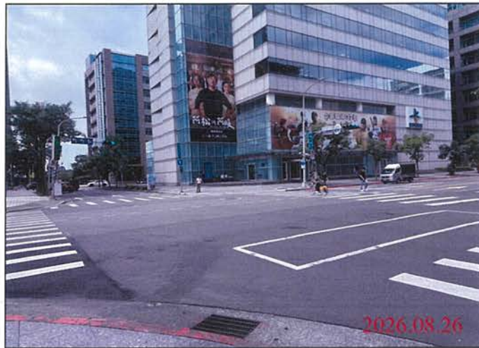
巡查日期地點：115.08.26 Y31車站 照片說明：路面狀況
