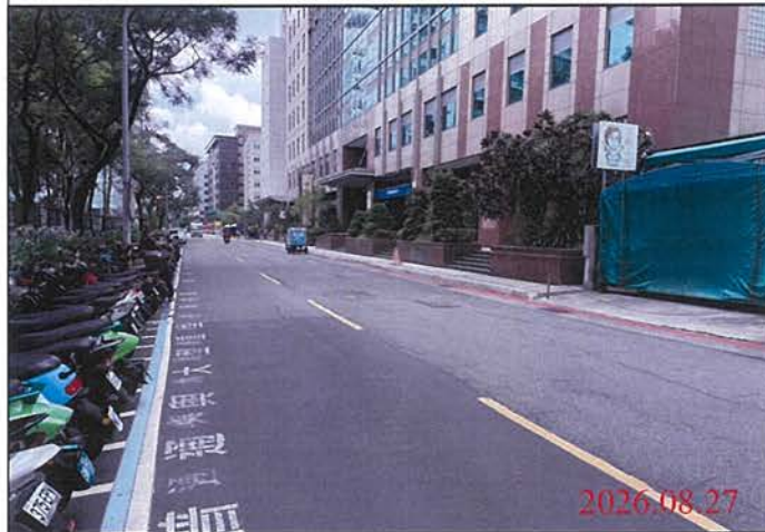
巡查日期地點：115.08.27 Y31車站 照片說明：路面狀況
