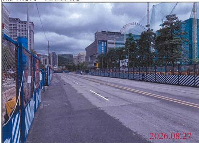
巡查日期地點：115.08.27 尾軌 照片說明：路面狀況
