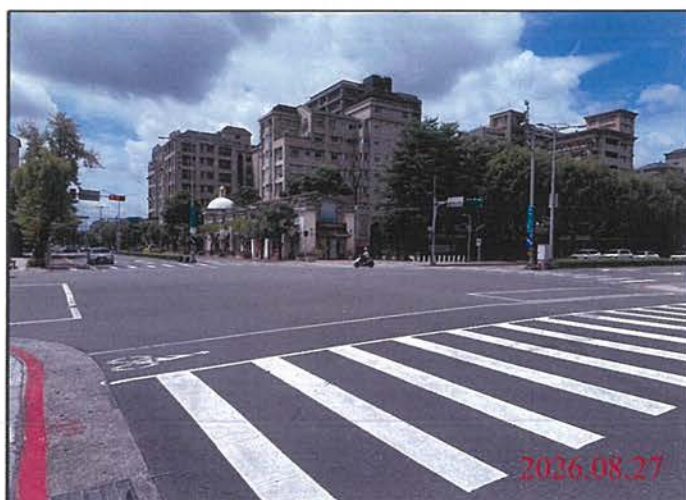
巡查日期地點：115.08.27 尾軌 照片說明：路面狀況
