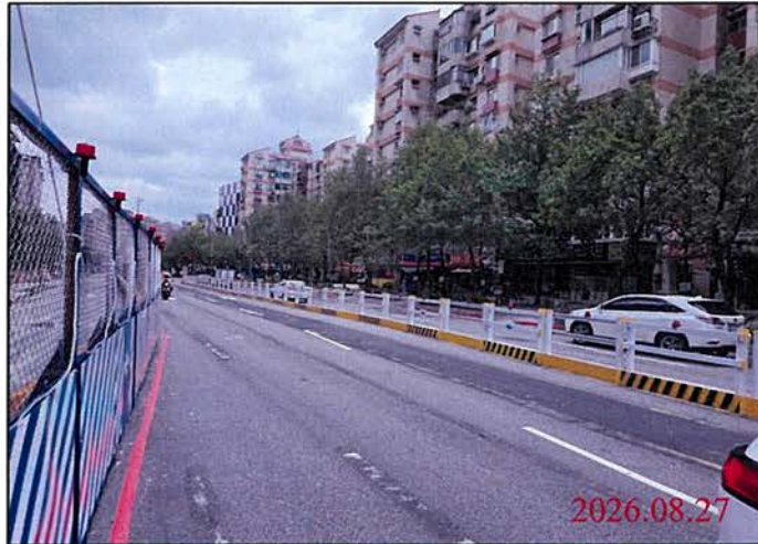
巡查日期地點：115.08.27 Y30車站 照片說明：路面狀況
