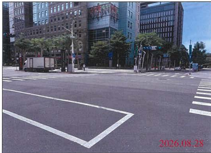
巡查日期地點：115.08.28 Y31車站 照片說明：路面狀況
