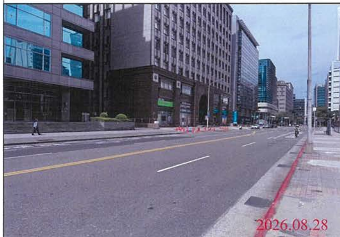
巡查日期地點：115.08.28 Y31車站 照片說明：路面狀況
