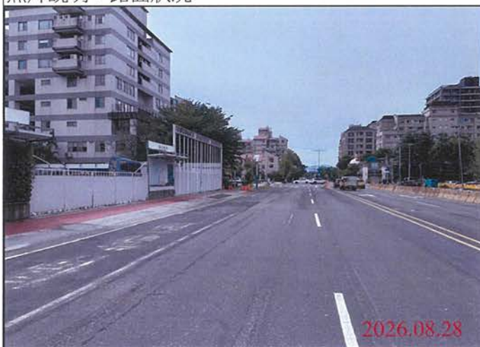
巡查日期地點：115.08.28 尾軌 照片說明：路面狀況
