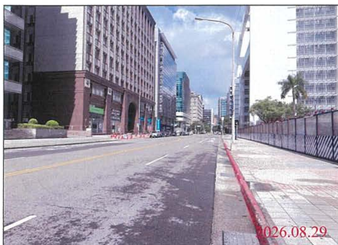
巡查日期地點：115.08.29 Y31車站 照片說明：路面狀況
