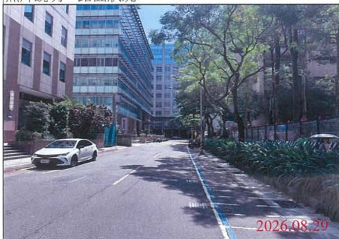
巡查日期地點：115.08.29 Y31車站 照片說明：路面狀況
