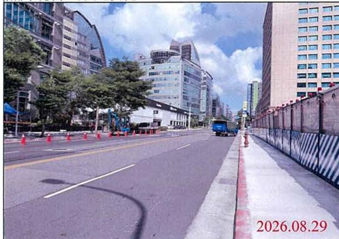
巡查日期地點：115.08.29 Y32車站 照片說明：路面狀況
