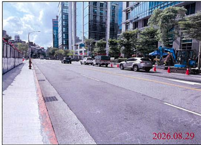
巡查日期地點：115.08.29 Y32車站 照片說明：路面狀況
