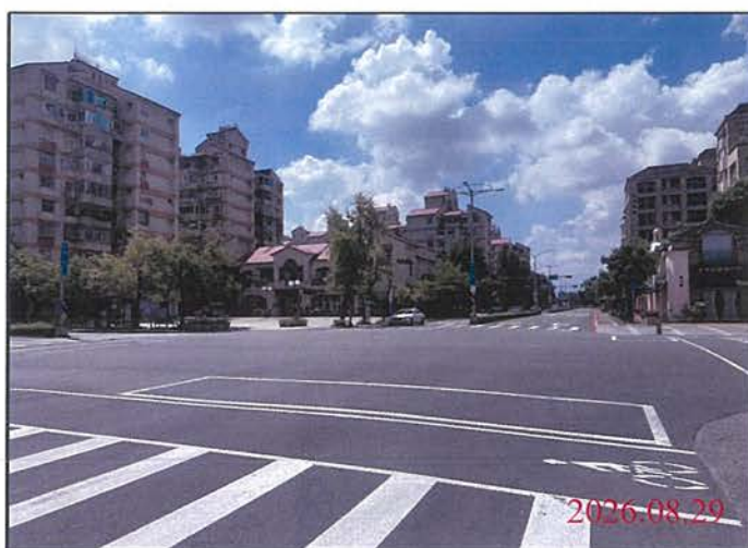
巡查日期地點：115.08.29 尾軌 照片說明：路面狀況
