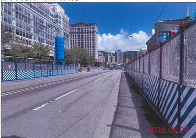
巡查日期地點：115.08.29 尾軌 照片說明：路面狀況
